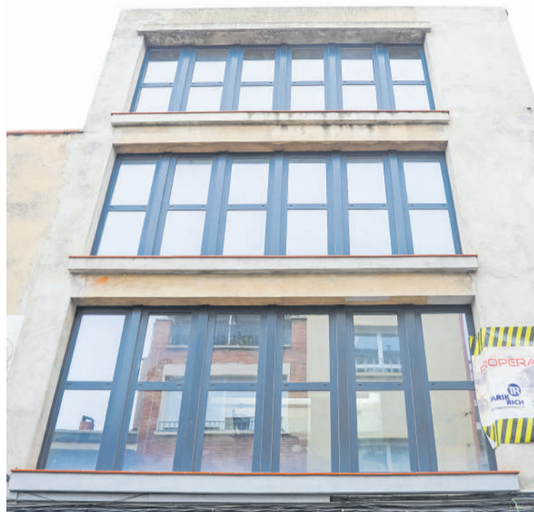
La nova seu, pendent de rehabilitació, al carrer del Pare Sallars / v.c.
