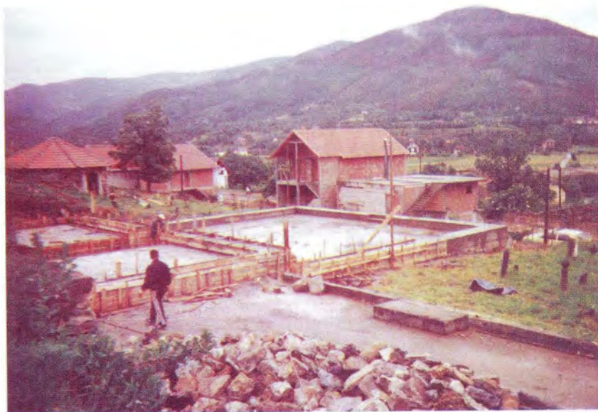
Radovi na izgradnji nove stare Turhan Emin-begove džamije su otpočeli, temelji su izbetonirani.
