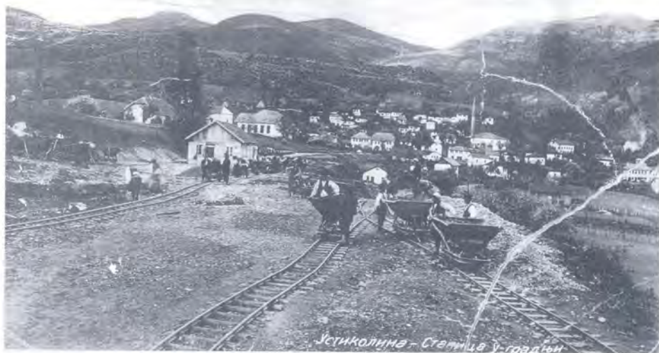
Ustikolina - stanica u gradnji
