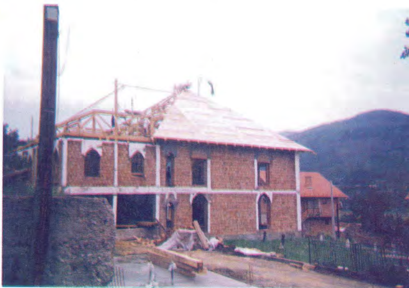
U fazi postavljanja krovne građe
