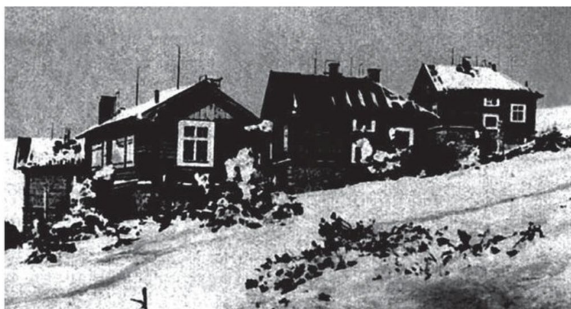
▲ Cliché datant de 1938 et montrant les chalets de la station de recherche de haute montagne « Goldhöhe », à la frontière tchécoslovaque. DR
