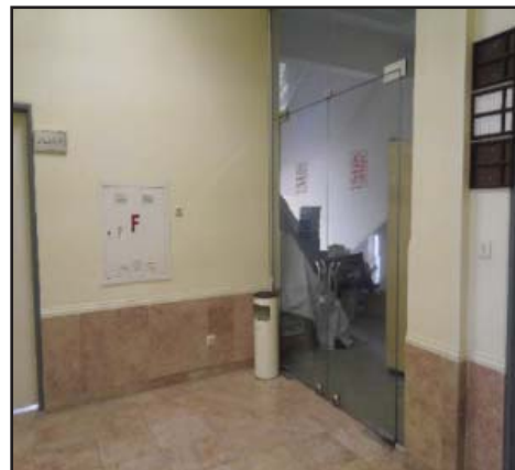
تصویر ۸: بسته بودن مسیرهای خروج اضطراری و یا مسدود بودن آن ها با لوازم جانبی. منبع: نگارندگان
