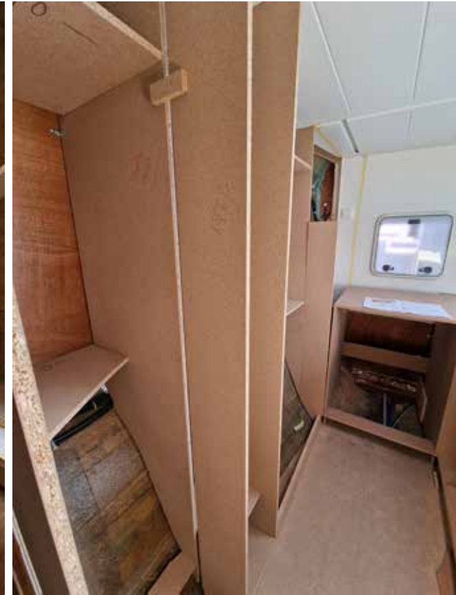
DURANTE I LAVORI
