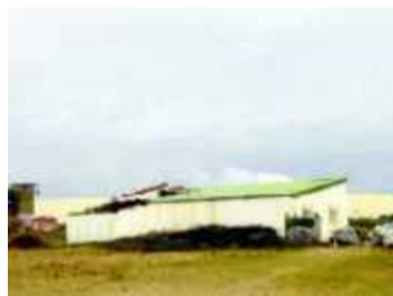
Une partie de la toiture du local des surfeurs de la Digue a cédé. PHOTO J.-Y.I.
