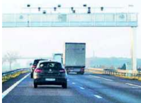
Un des 160 portiques à démonter. ARCH. « SO »
