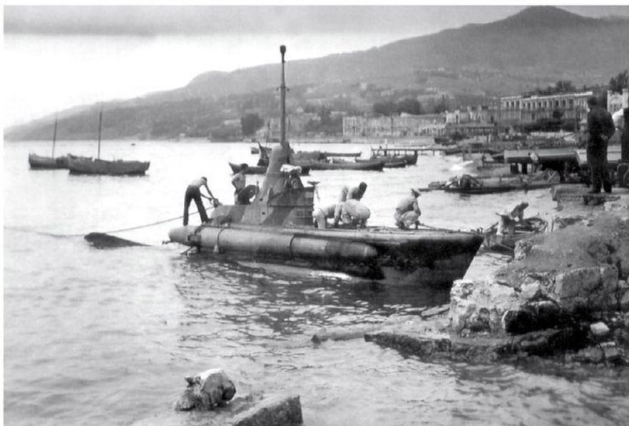
▲ Un sous-marin de poche italien en 1943. Il appartient à la classe CB, une version améliorée d'engins conçus en 1938 (classe CA) pour être acheminés par des sous-marins pour être transportés jusqu'à leurs cibles. Coll. Tracal
