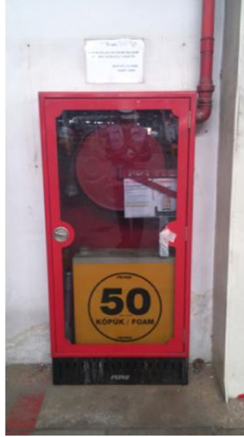
Şekil 7. Hes Kablo’da Köpük Dolabı Uygulaması
