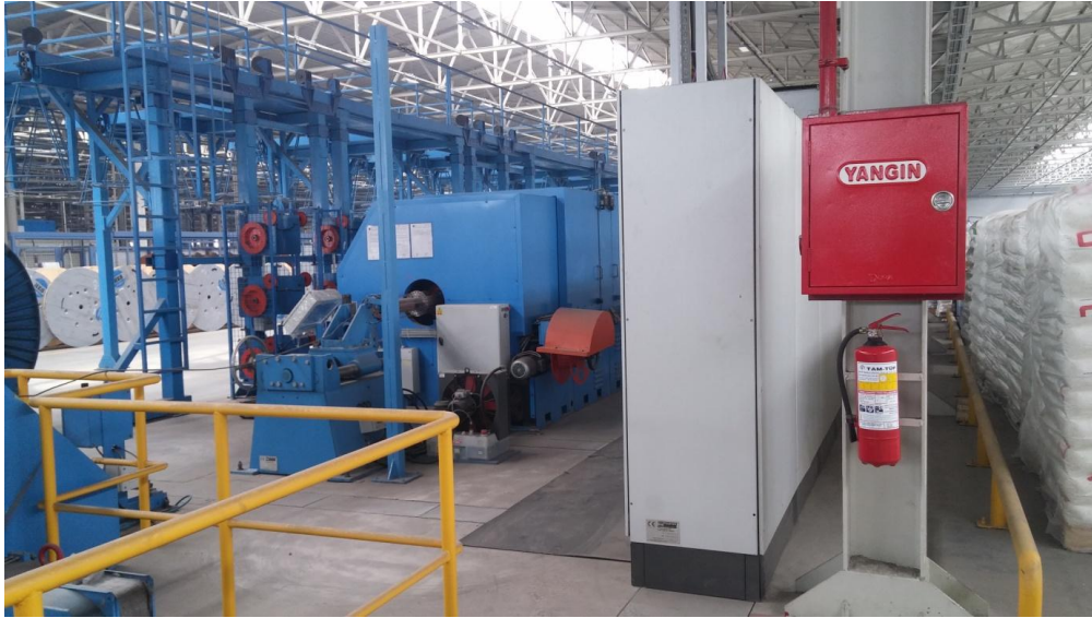
Şekil 4. Makine bazında yangın dolabı ve yangın tüpü uygulaması
