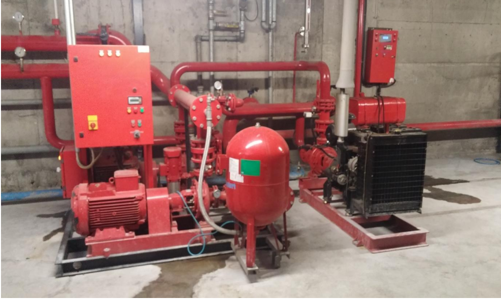
Şekil 8. Fabrika da ki elektrikli yangın önleme sistem pompaları
