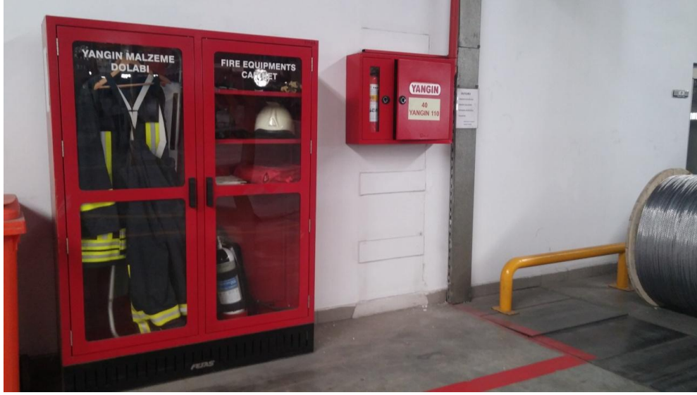
Şekil 3. Yangın dolabı
