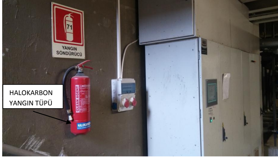
Şekil 5. Halokarbon tüp uygulaması
