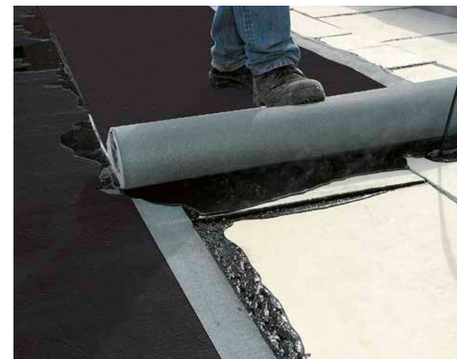
Erste Abdichtungslage BauderKOMPAKT ULK eingießen
