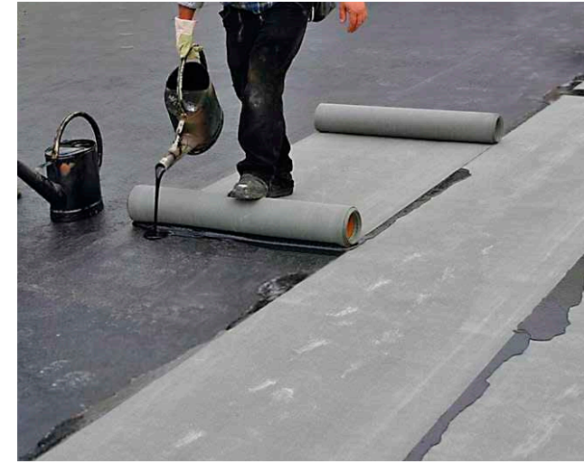
Dampfsperre BauderKOMPAKT DSK eingießen
