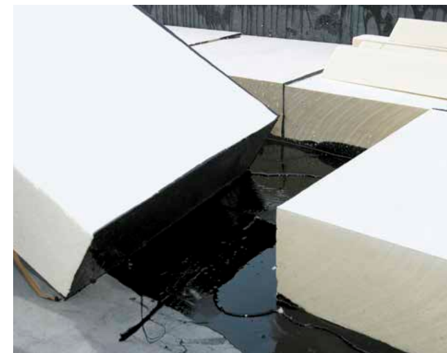
Wärmedämmung BauderPIR KOMPAKT eingießen
