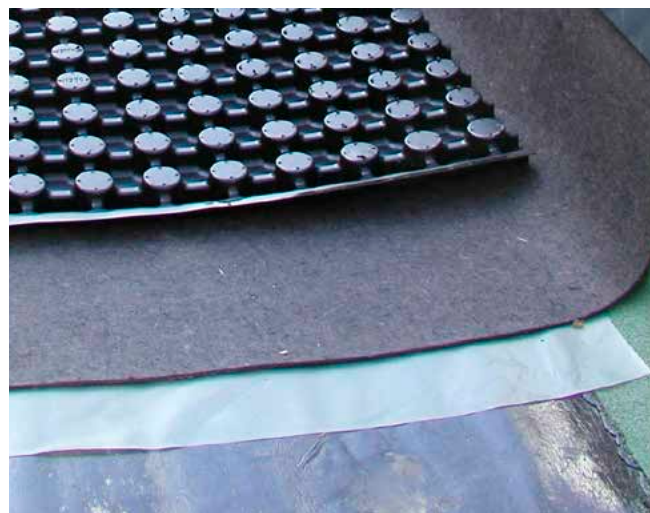
Trennfolie PE 02 und Faserschutzmatte FSM 600 aufbringen
