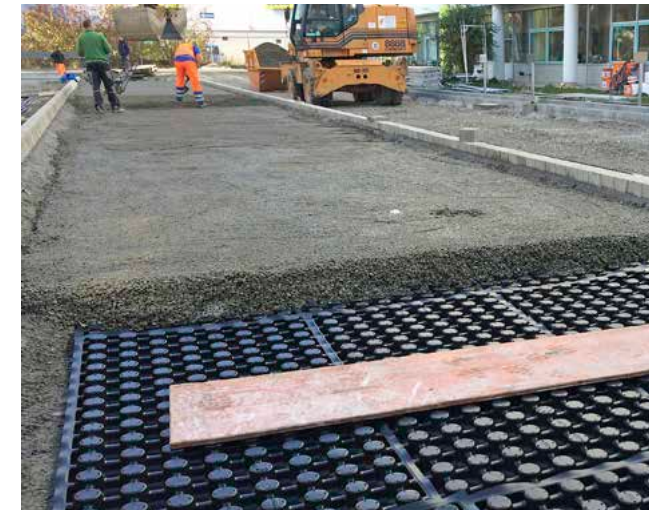
Tragschicht einbringen
