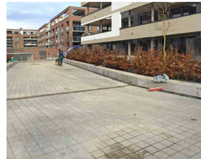
Betonpflaster auf Splittbett
