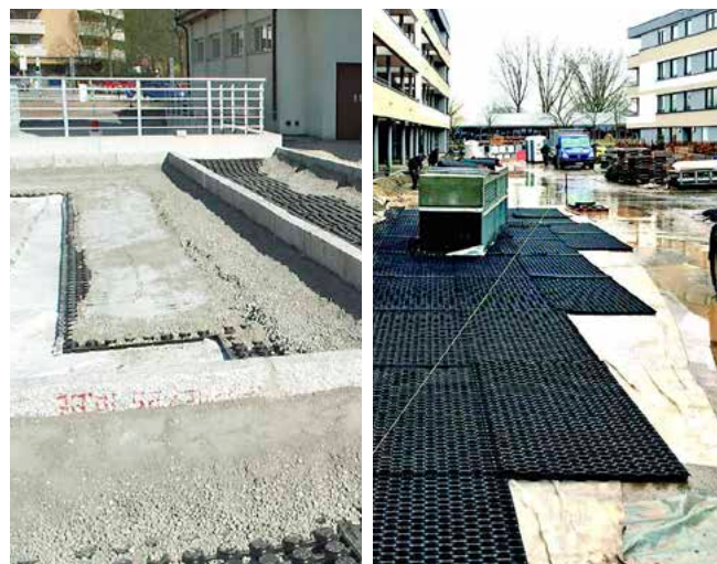
Bauder Drän- und Speicherelement DSE 40 verlegen
