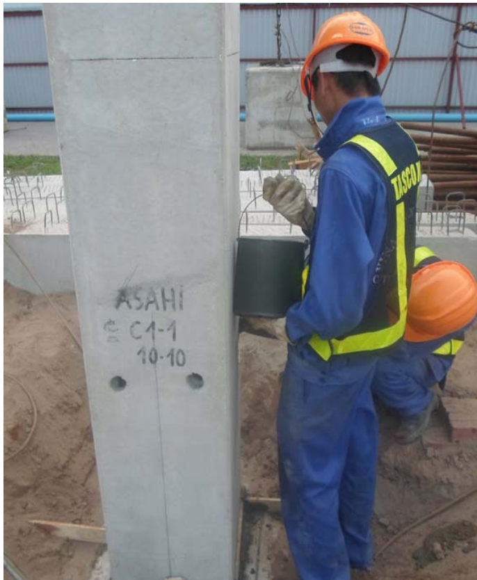
ĐỔ VỮA KHÔNG CO POURING NON-SHRINKAGE MOTAR
