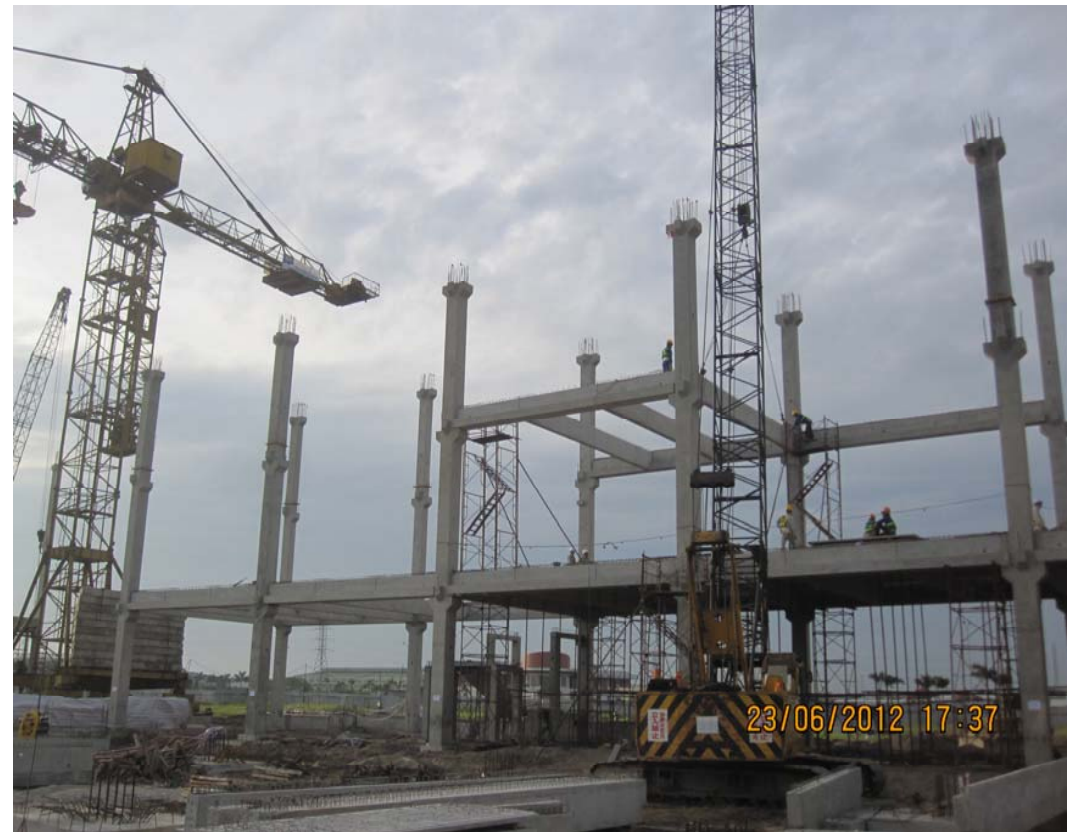
THI CÔNG LẮP DỰNG DÀM ERECTING BEAM
