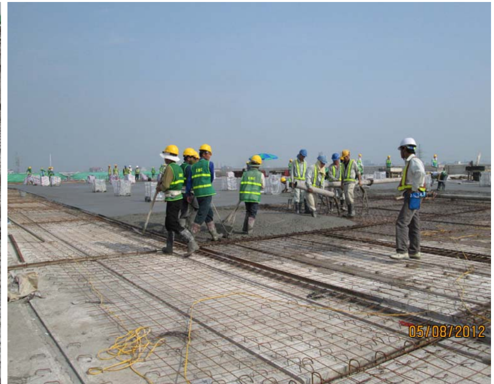
ĐỔ BÊ TÔNG SÀN CONCRETE FOR TOPPING
