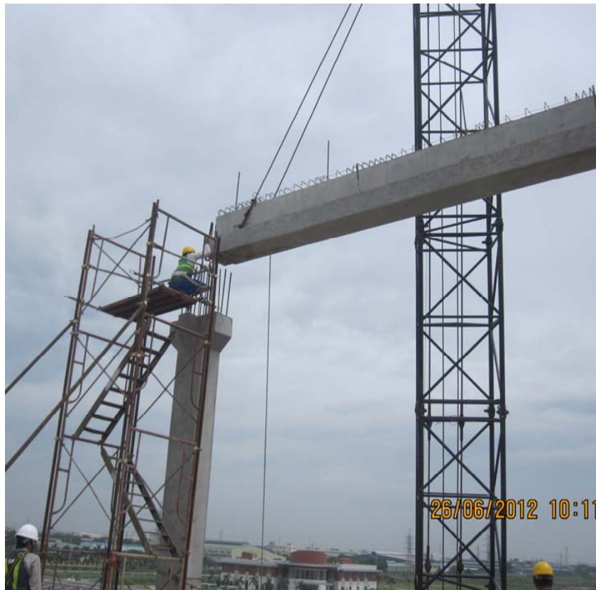
THI CÔNG LẮP DỰNG DÀM ERECTING BEAM
