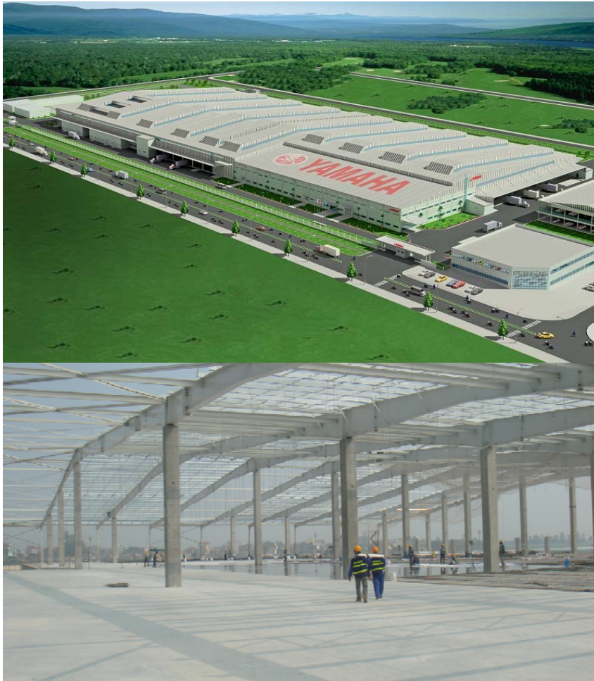
NHÀ MÁY YAMAHA/ YAMAHA FACTORY, SPAN OF 20M
