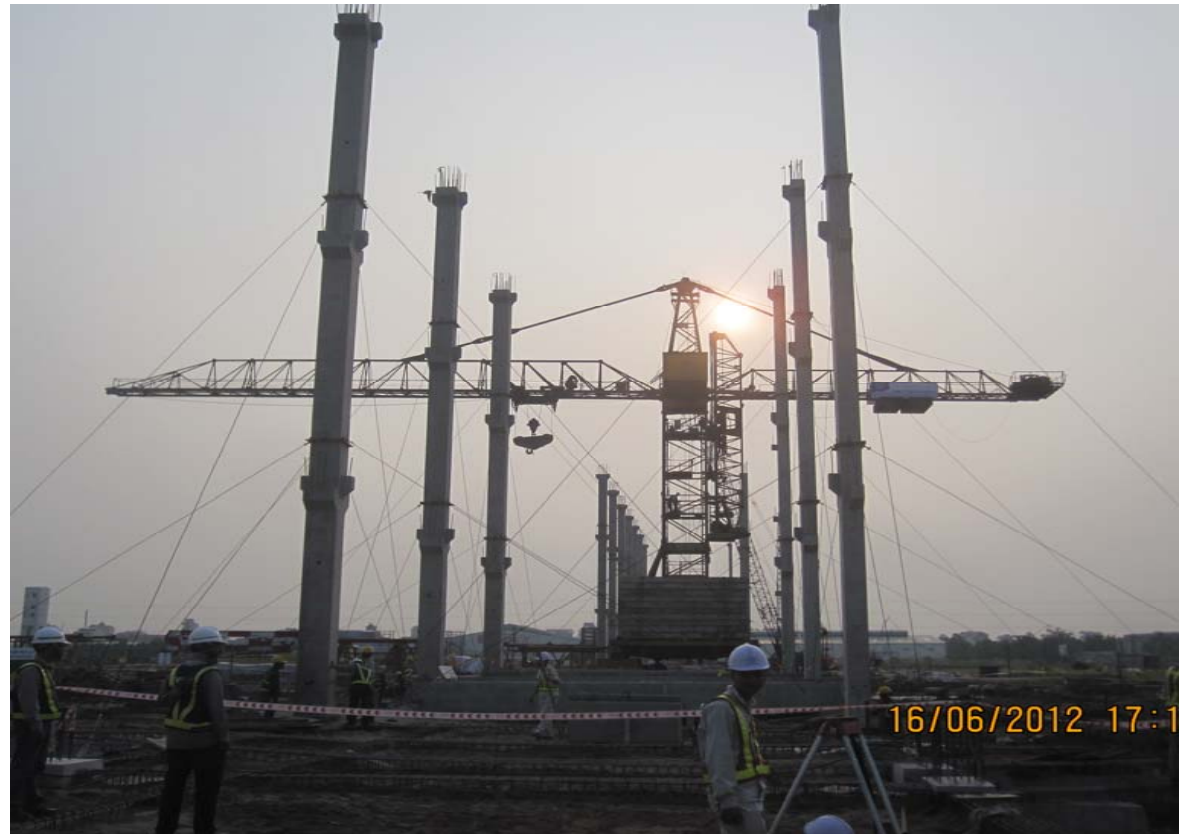
CĂNG CÁP NEO GIỮ ANCHORING CABLE
