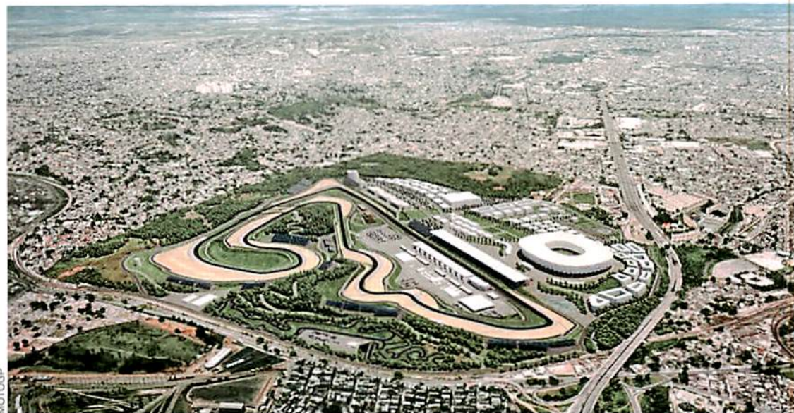
Gleich am Stadtrand: Die neue Strecke entsteht auf dem ehemaligen Olympia-Areal am Westrand von Rio de Janeiro
