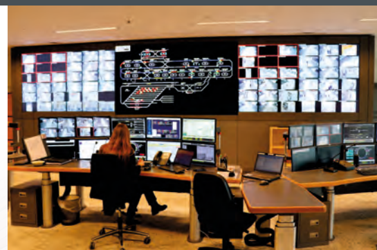
Control Room della metro in esercizio
