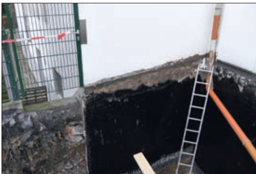
Freilegung und Abdichtung des Kellers im Bereich Schießraum und Kegelbahn
