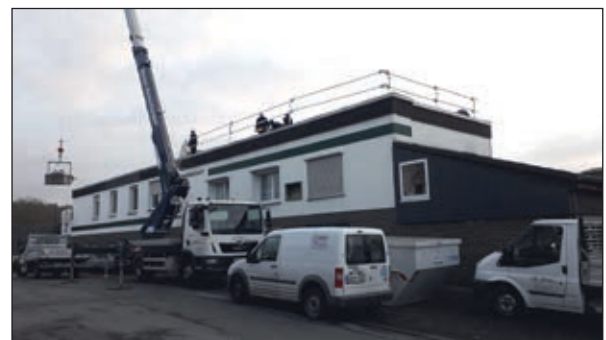
Erneuerung Dach Hausmeisterwohnung
