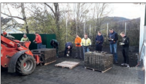
Aufnahme des alten Pflasters
