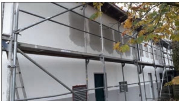
Verputzung Fensteröffnungen und Abdichtung Dach
