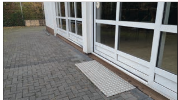
Schiebetüren alt mit Stufen
