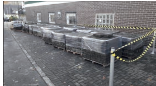
Zwischenlagerung der Pflastersteine
