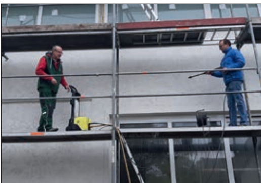
Säuberung und Anstrich Außenfassade
