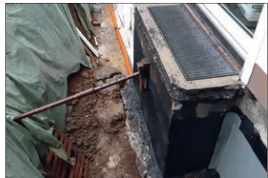
Freilegung und Abdichtung des Kellers im Bereich Schießraum und Kegelbahn
