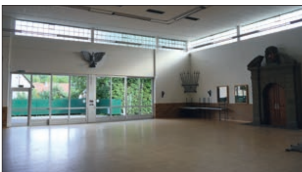
Innenansicht vor dem Umbau
