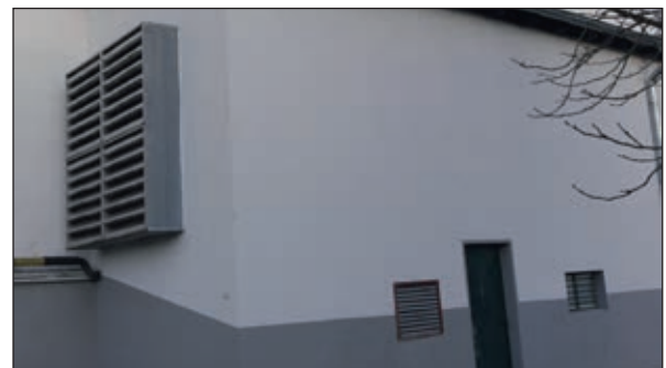
Nach der Renovierung
