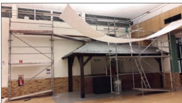
Ausbau der Glasbausteine
