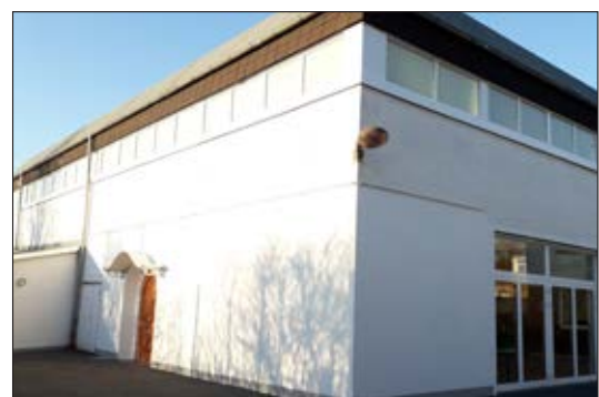
Außenansicht nach dem Umbau
