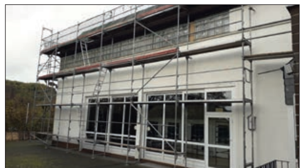
Ausbau Glasbausteine und Abdichtung Dach
