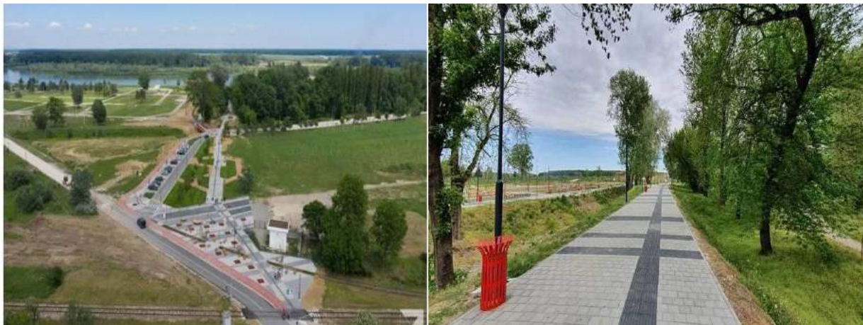
сл. 7 и сл.8 . Савска авенија после реконструкције
