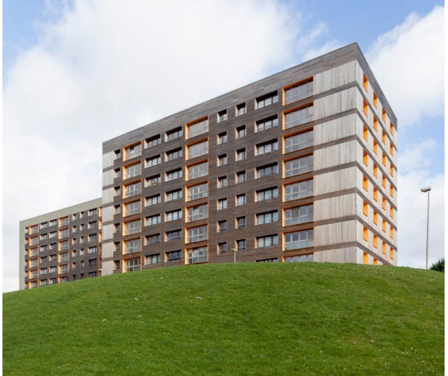
La cité Yvernaux / Maître d'ouvrage : La Sambrienne / Architecte : Baneton Garrino © Marie-Noëlle Dailly
