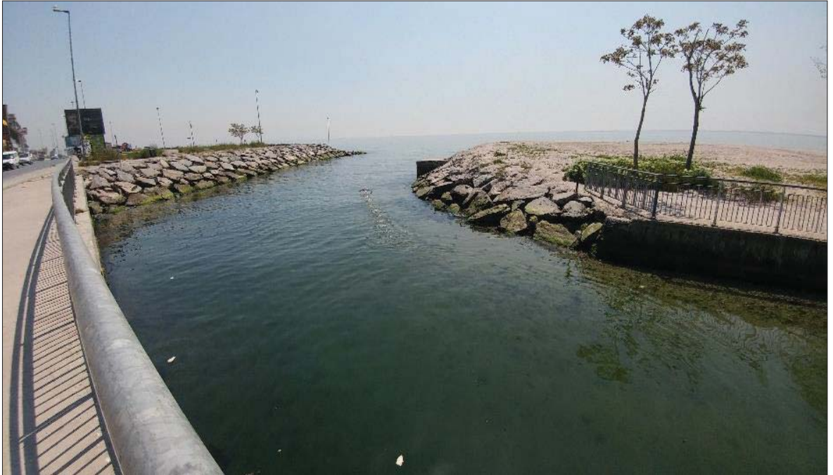
Şekil 5.12.1.1.1.3. Küçükçekmece Kanalının Marmara Denizine Açıldığı Bölge-1
