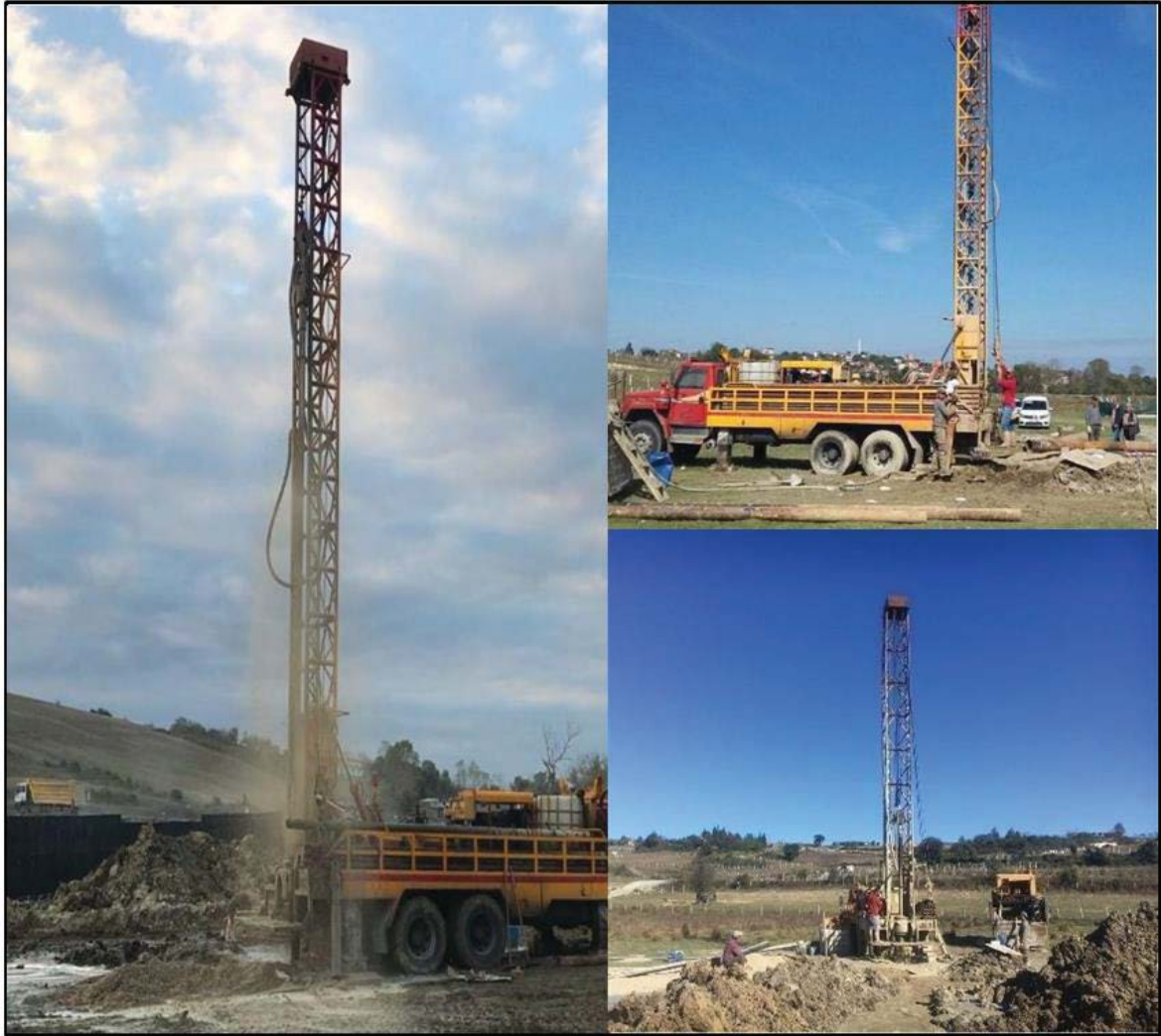
Şekil 5.9.18. Pompa Kuyuları İnşa Çalıřmaları
