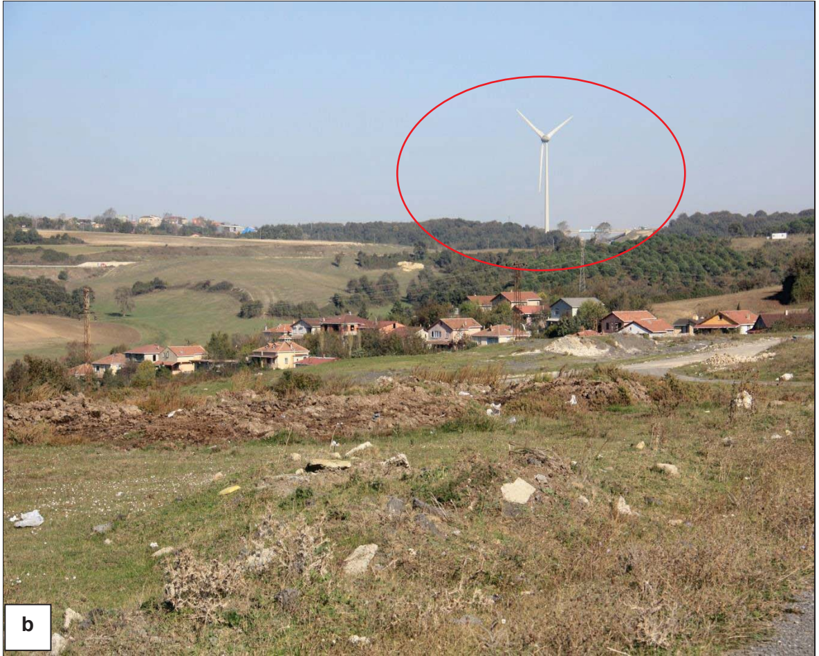
Şekil 4.5.8.20 a. Kemerburgaz RES Proje Alanının Konumu b. Kemerburgaz RES Projesi Türbinlerinden Görünüm
