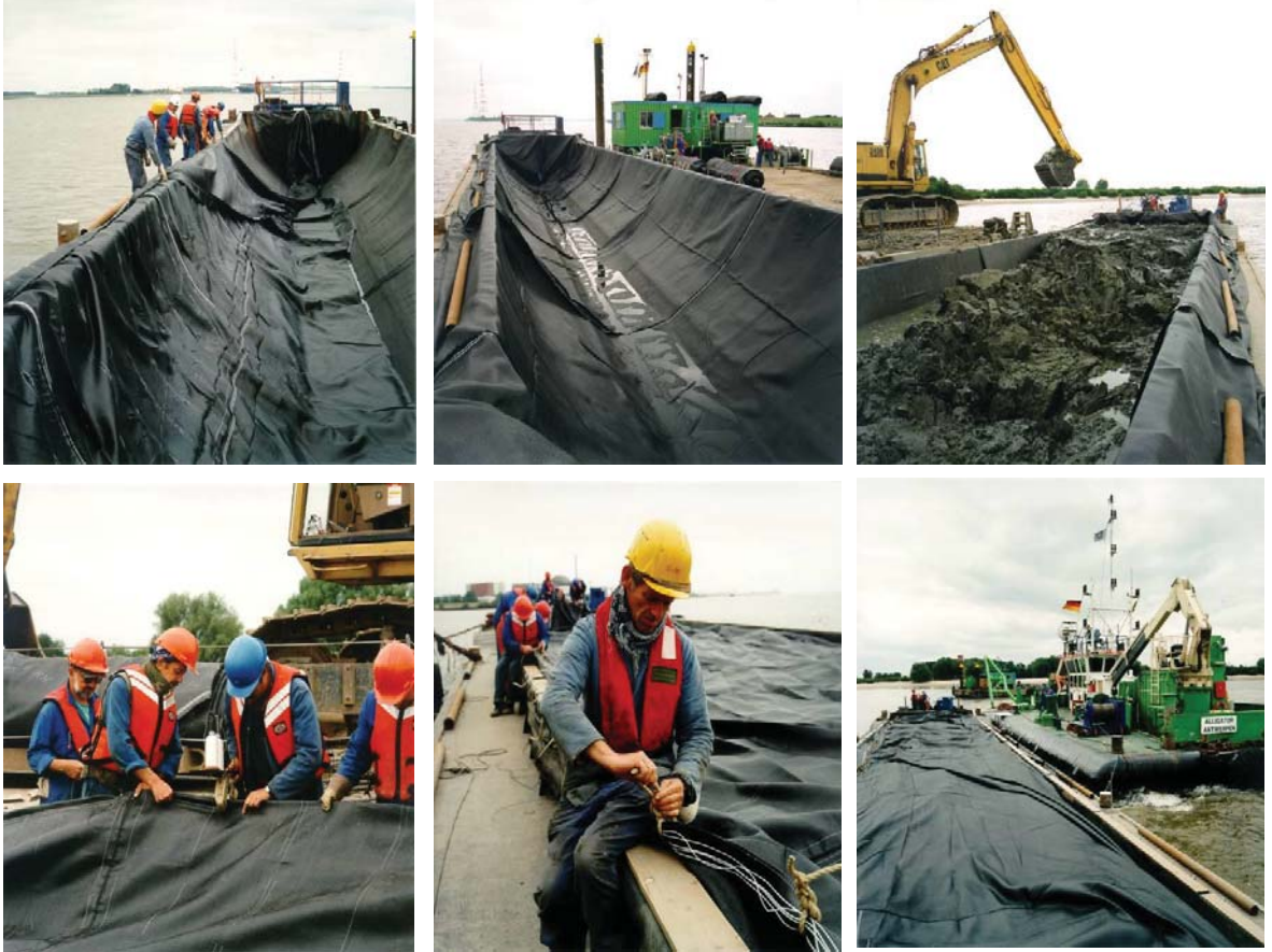
Şekil 3.2.7.6.1. Geocontainer Hazırlık Aşamaları
