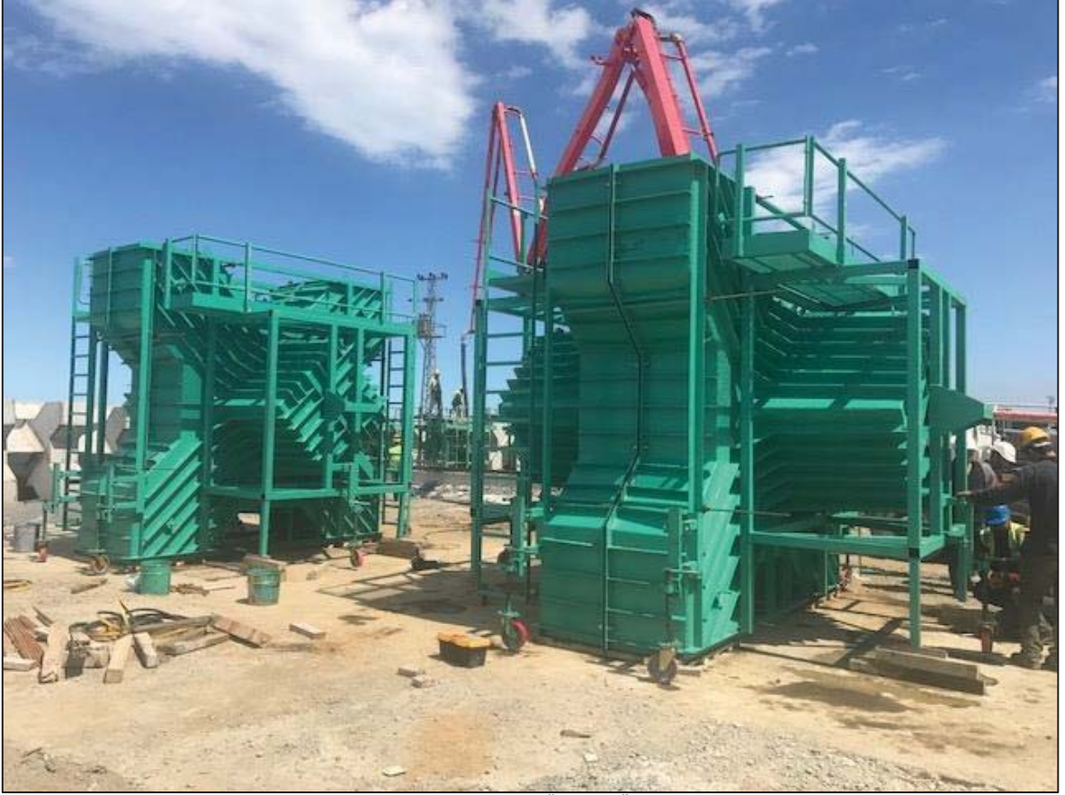
Şekil 3.2.4.10.4. Xbloc Beton Blok Kalıplarının Sahada Üretimi (Örnek olarak verilmiştir)
