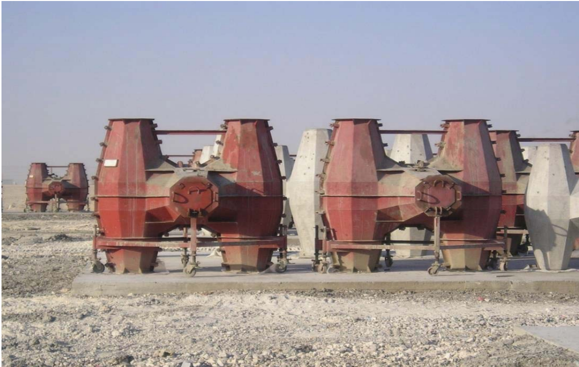
Şekil 3.2.4.10.7. Core-loc Beton Blok Kalıplarının Sahada Üretimi (Örnek olarak verilmiştir)
