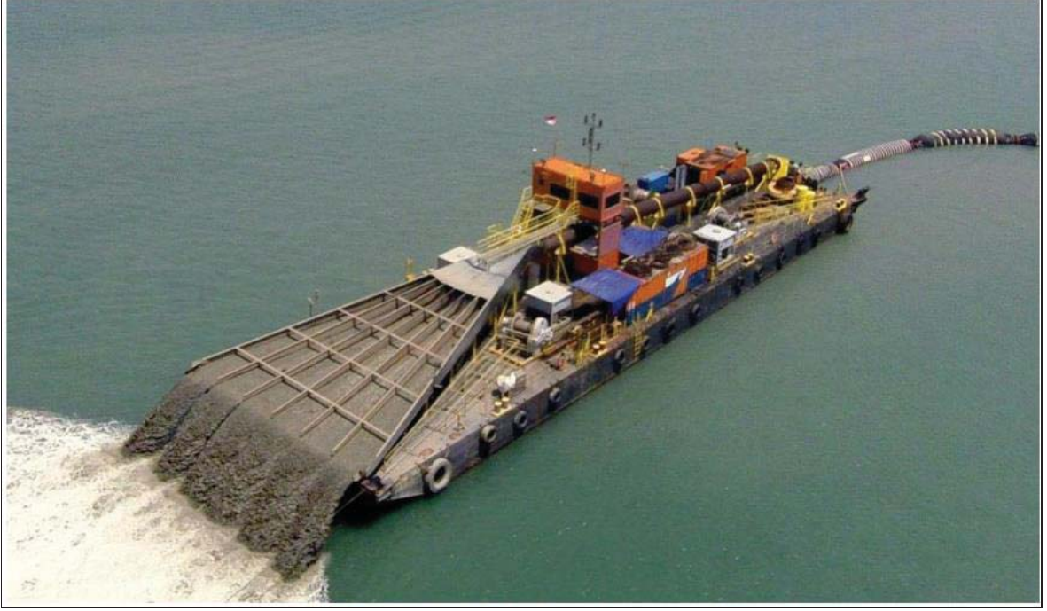
Şekil 3.2.8.5.1. Spray Ponton ile Deniz Dolgusu
