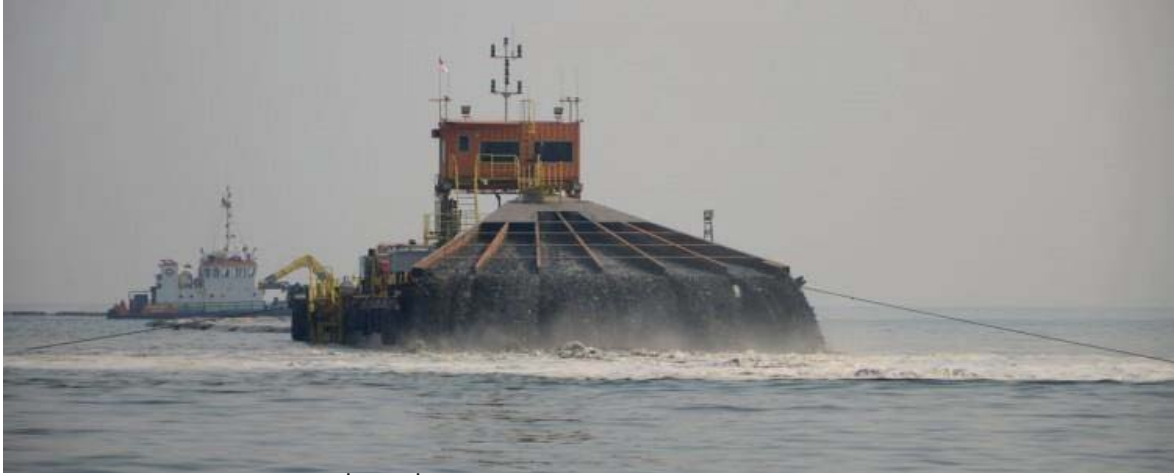
Şekil 3.2.4.9.1. Dalgakıran İnşaatı İçin Deniz Dolgusu (Çekirdek Dolgu)
