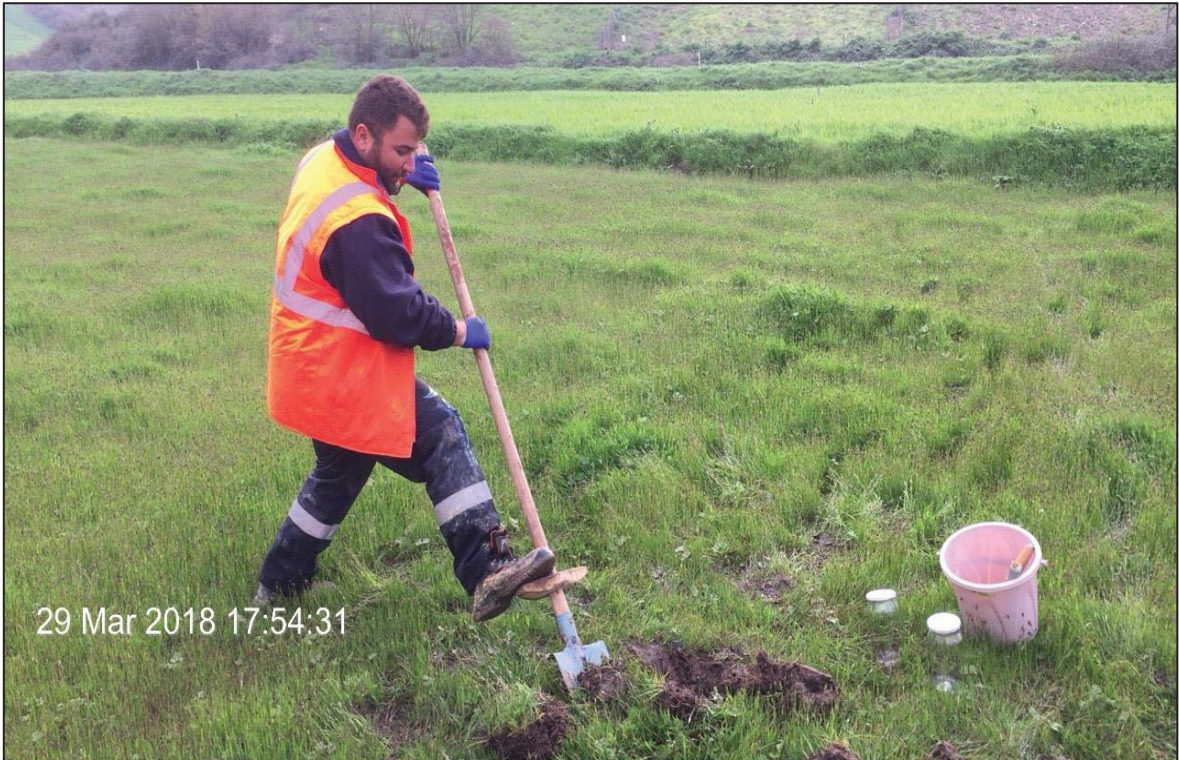
Ŗekil 5.2.6. Toprak Numunesi Alımı Çalıřmalarından Grnm
