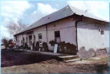
Rekonštrukcia materskej školy
