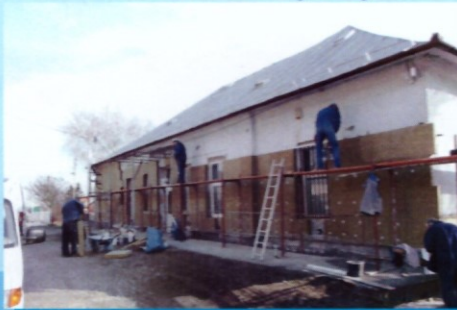
Rekonštrukcia materskej školy
