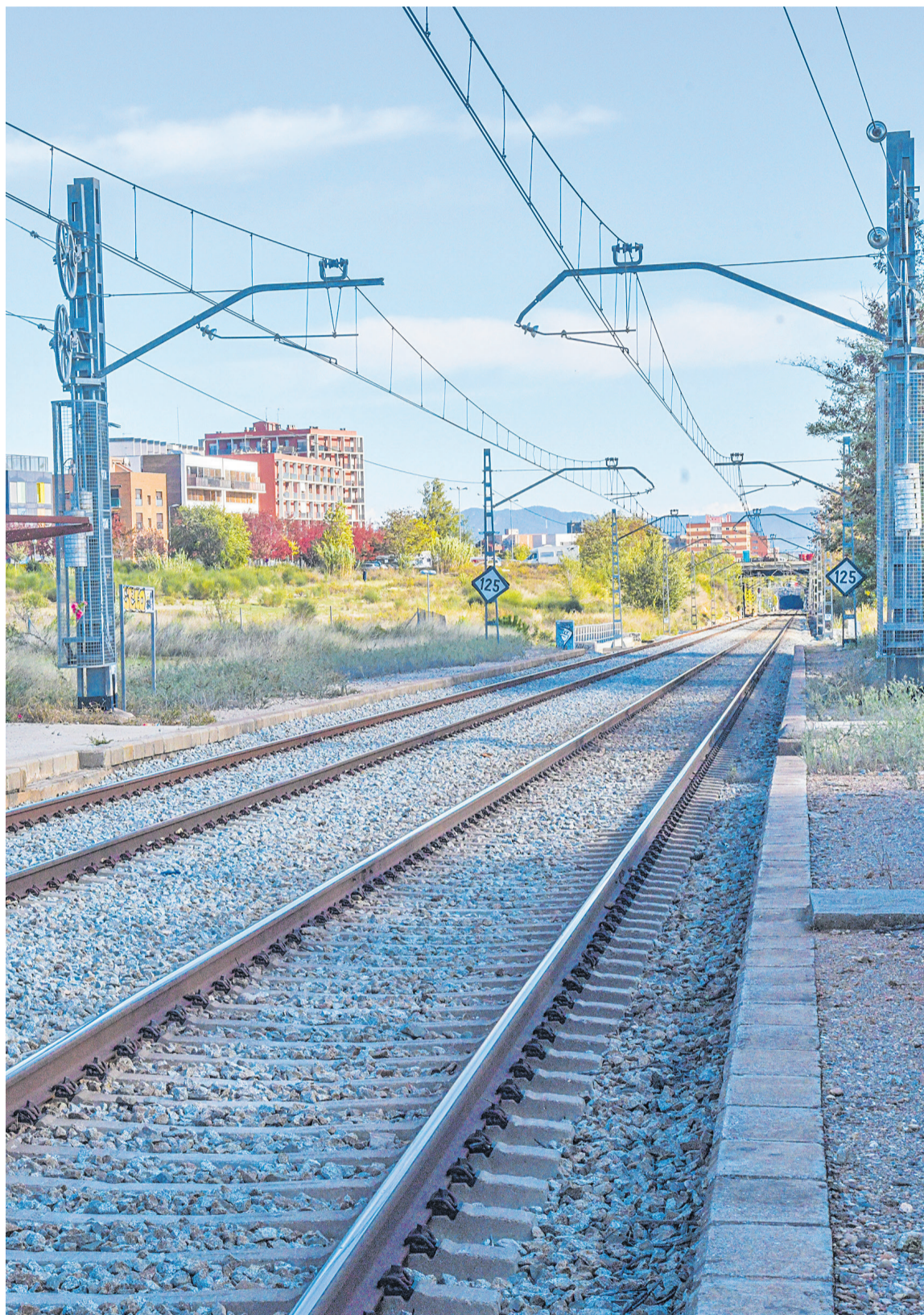
Imatge d'arxiu d'un tram de via de l'R4 de Rodalies a Sabadell / LLUÍS FRANCO
