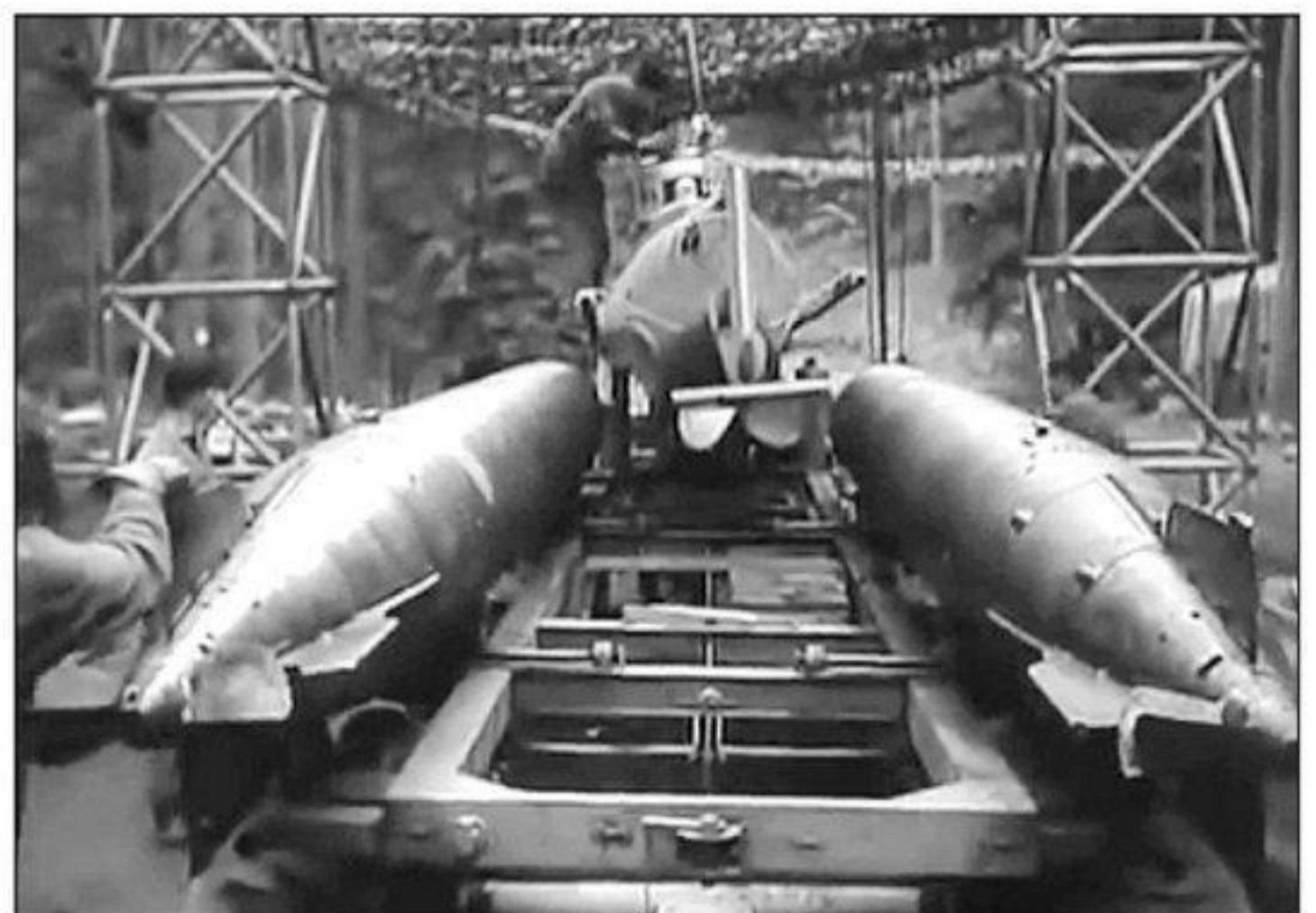
Le Biber est amené sur un support positionné entre les deux torpilles à arrimer. (Vidéo Bundesarchiv)
