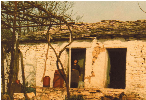
Η οικία Β.Κ. Δρόσου μετά τον σεισμό. στην πόρτα η Βάσιω (1981) Αθαν. Γρ. Στράτη (1974)
