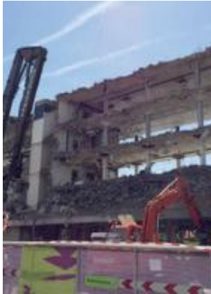
Voordat er kan worden gebouwd, moet er eerst worden gesloopt, zoals hier in Utrecht. EIGEN FOTO
