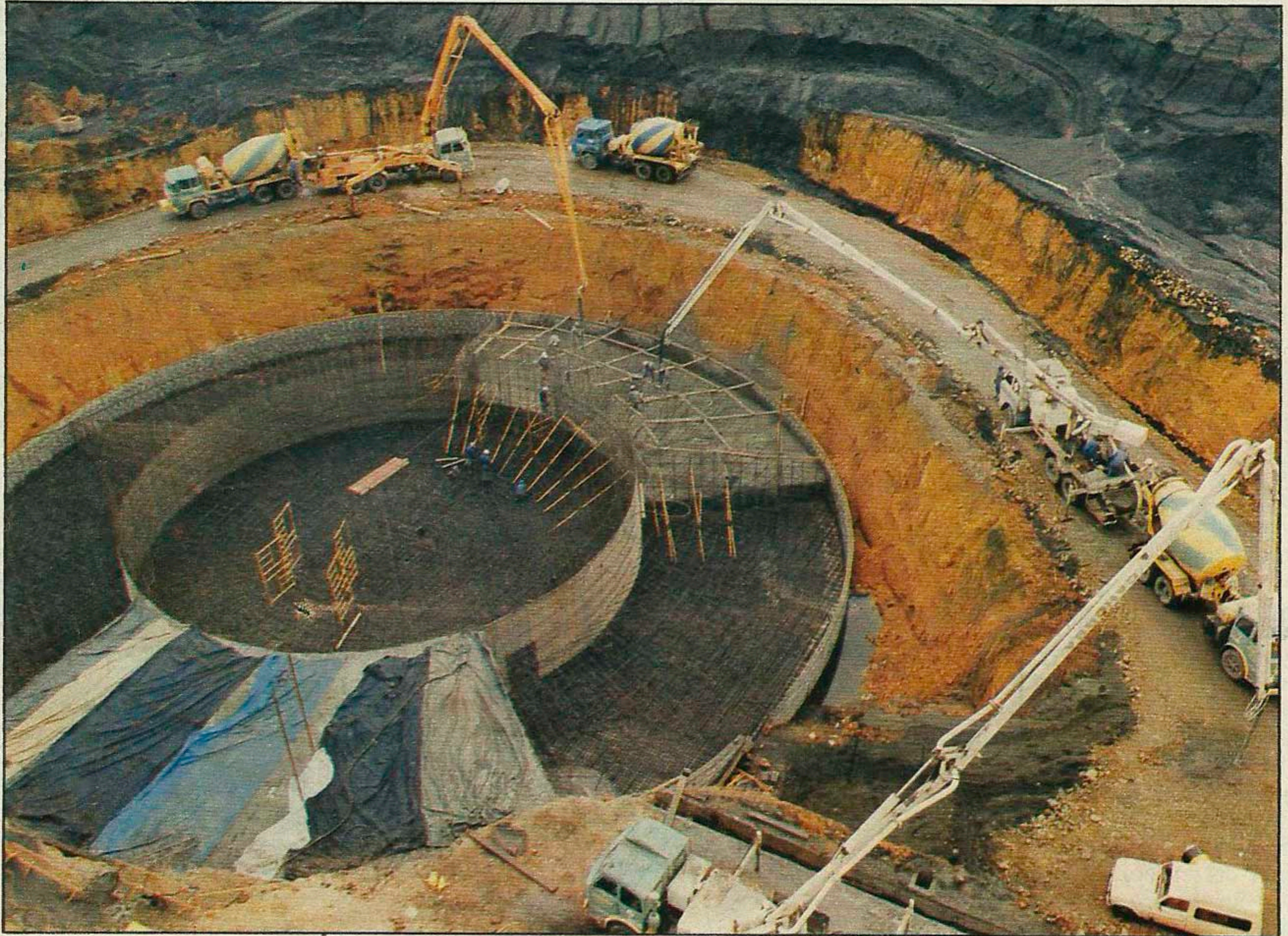
(Cimentación chimenea Compostilla II (290 m. de altura). Situación 5-3-85)
