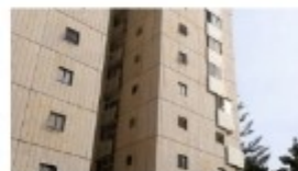
קשיש כבן 70 נפל מהקומה ה-11, אל פיר חדר המדרגות שבבניין, ונפצע באורח אנוש (צילום: יח"צ)
