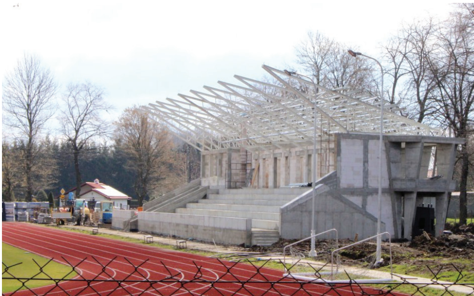
Budowa trybuny na stadionie Żurawianki w Żurawicy
