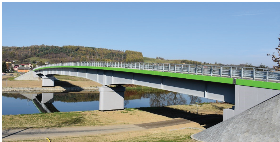
Most na Sanie w Sielnicy (gm. Dubiecko)
