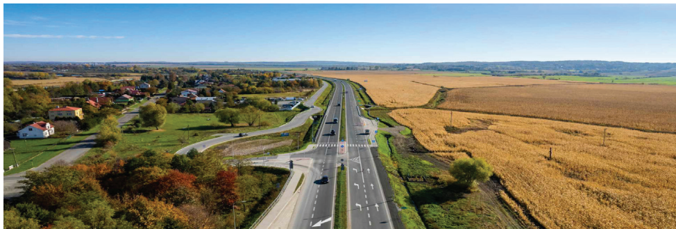
Przebudowana droga krajowa nr. 28 Przemyśl - Medyka
