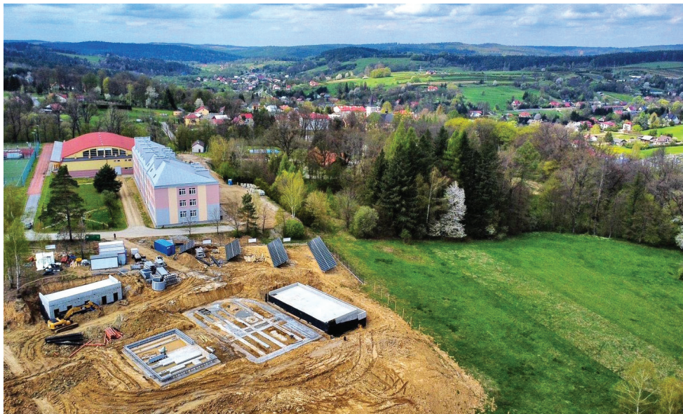
Budowa kompleksu basenów w Birczy
