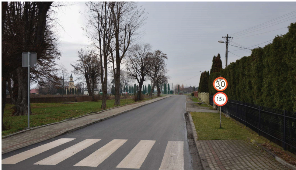
Przebudowa drogi Hurko-Hureczko
