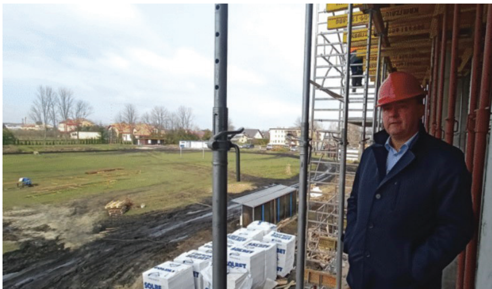
Budowa stadionu w Orłach
