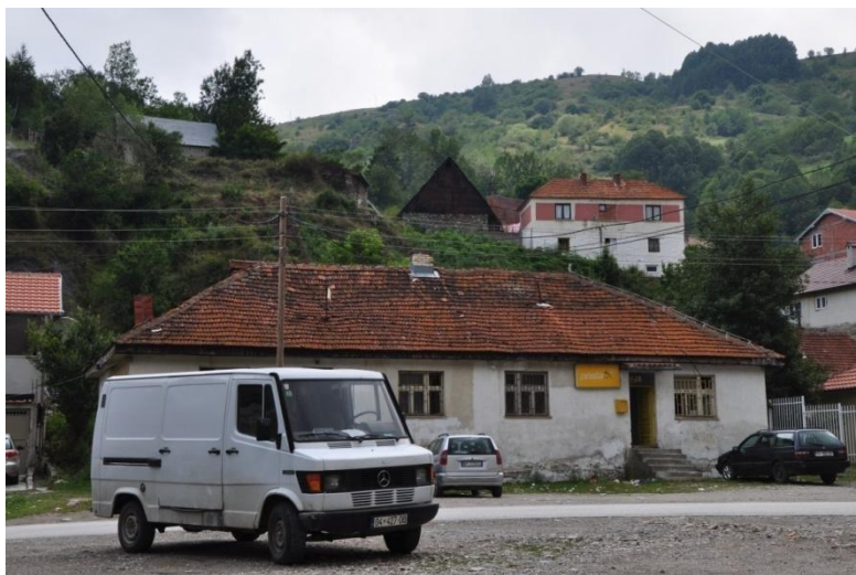
Zgrada matične službe i pošte (prije požara)
