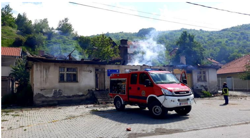
Požar na zgradi matične službe i pošte 10.06.2019. godine
