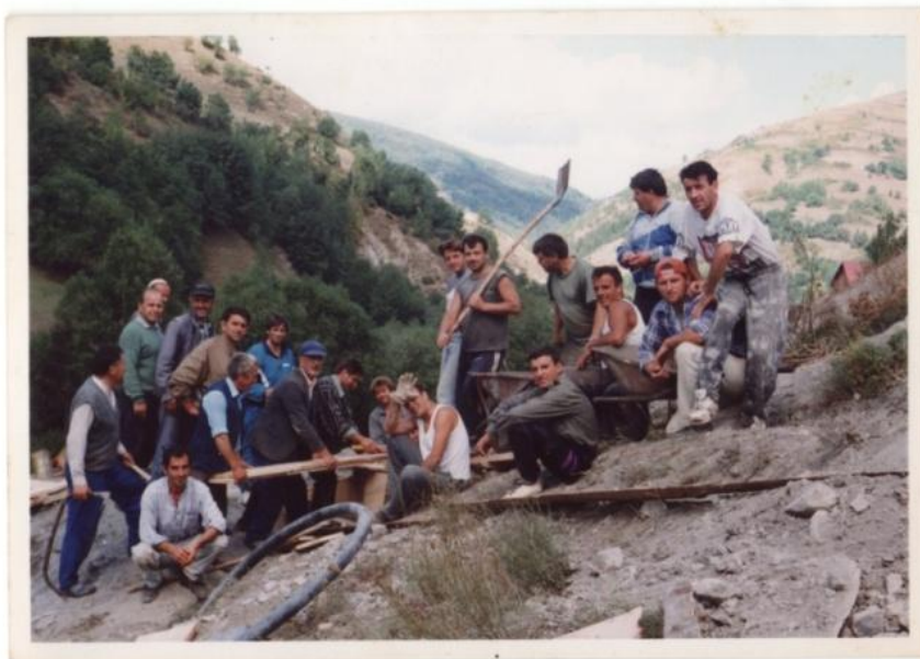
Izgradnja vodovoda Gornje mahale 1994. godine
