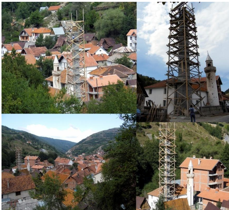
Izgradnja munare 2009. godine
