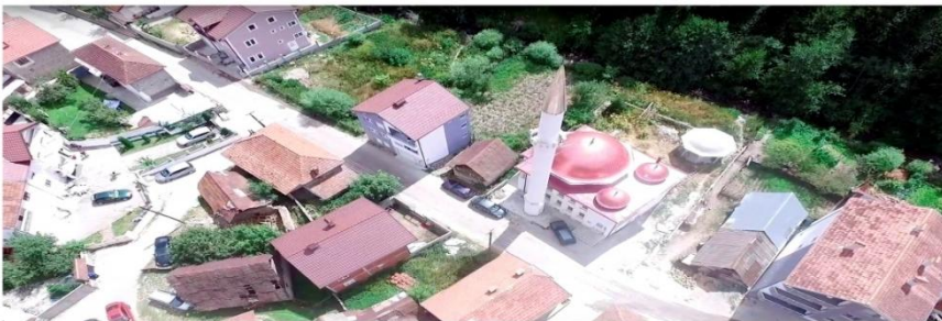
Izgradnja džamije 2015-2017. godine
