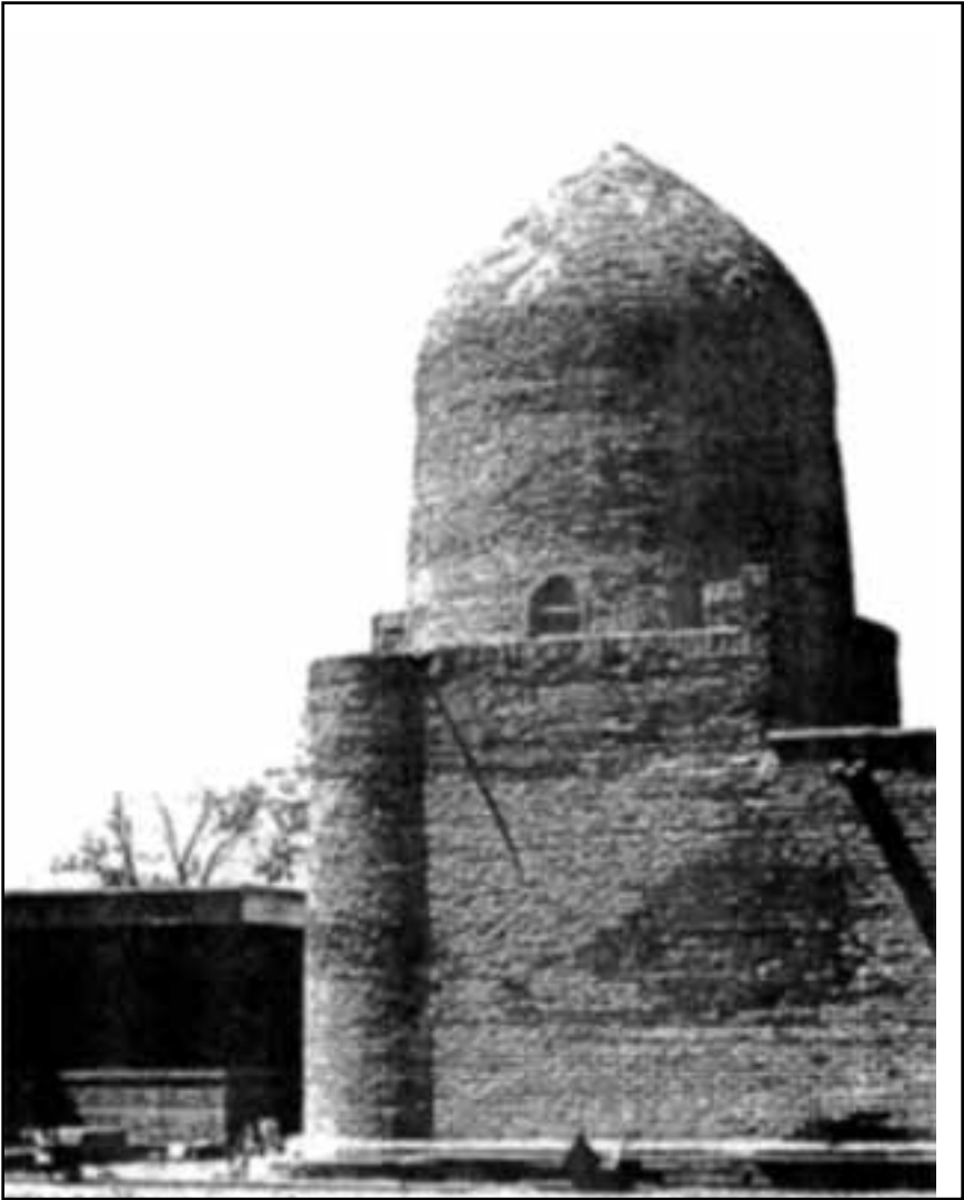
تصویر شماره ۵- ساختمان مقبره استر قبل از طرح توسعه
