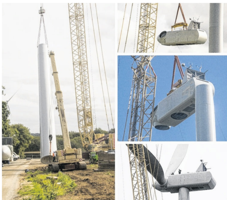
La fixation d'une pale de l'éolienne E4 sur le site de Plésidy.
