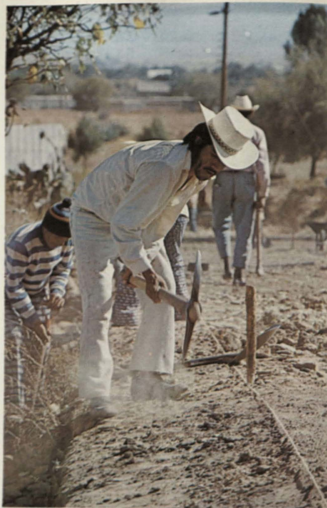
Formación de cunetas y afinamiento en material tipo "B".
