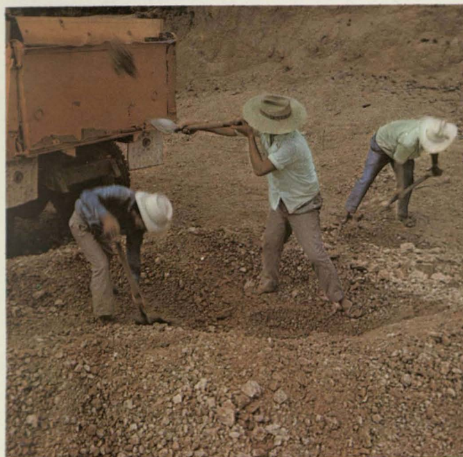
Carga de revestimiento y acarreo por medio de camiones.
