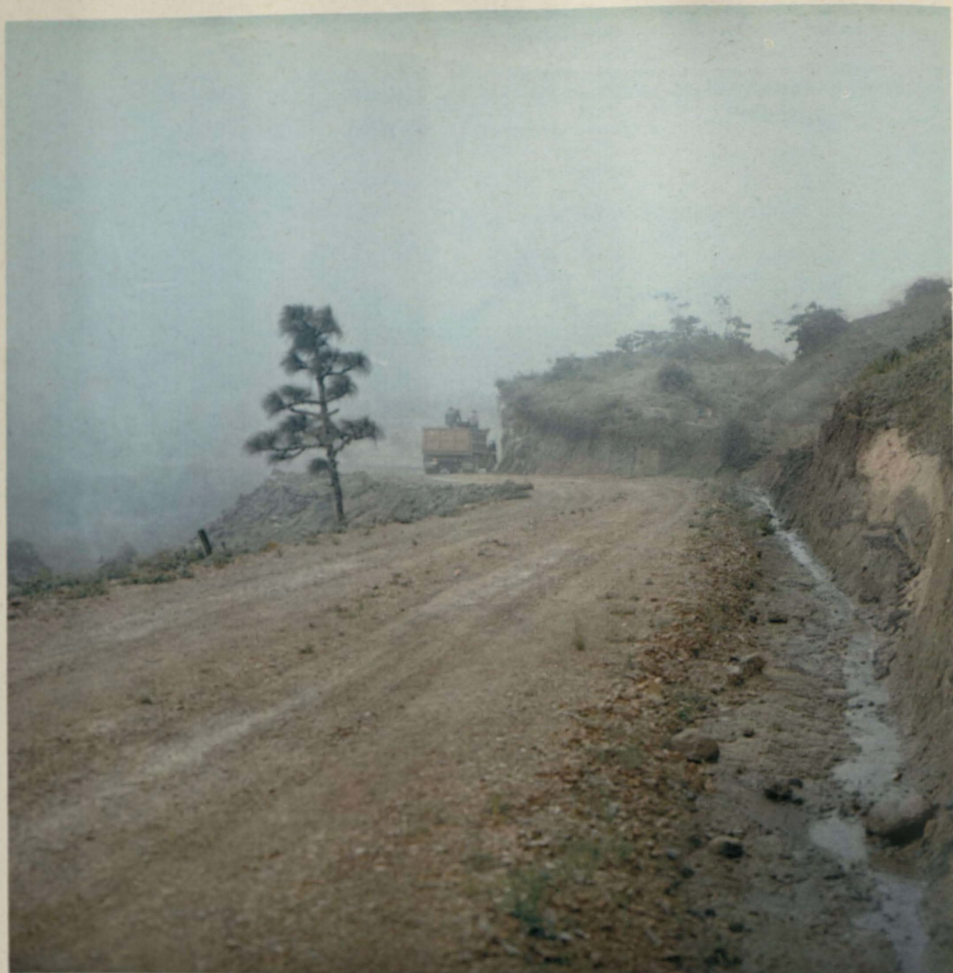
El tránsito no se ve afectado por la época de lluvias.
