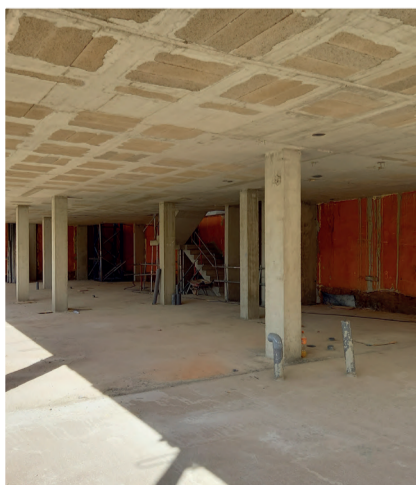
Estat de l'obra octubre 2021
