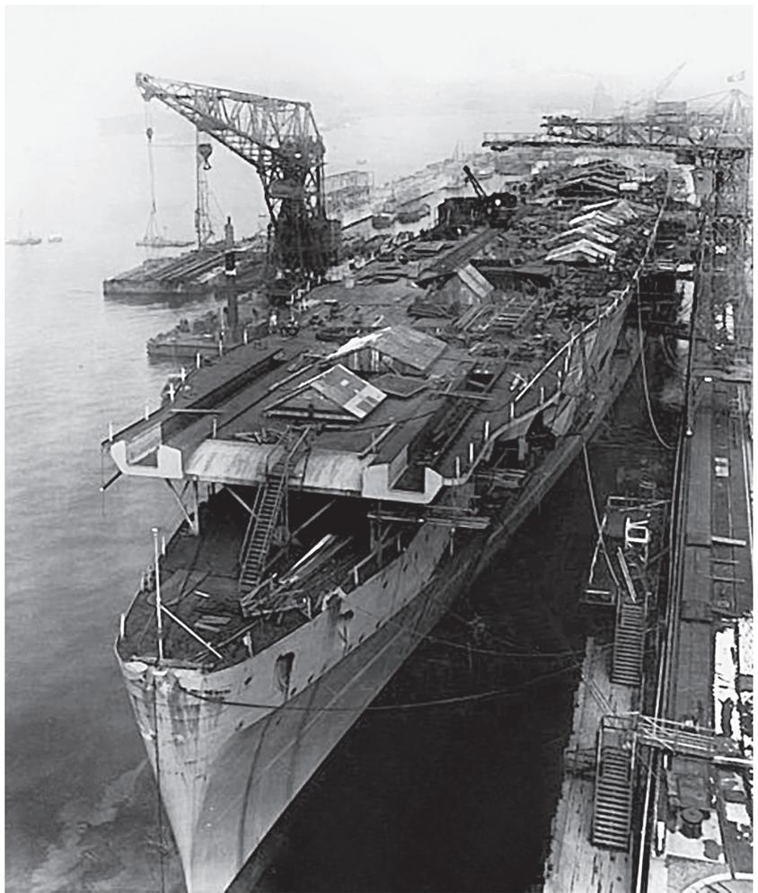
▲ Le *Graf Zeppelin* dans son état de construction en date du 22 mars 1939. Les emplacements réservés aux deux catapultes sont bien visibles à l'avant du pont d'envol. La fin du chantier est alors prévue dans un an, le 13 mars 1940, mais des retards amèneront à repousser la date au 1<sup>er</sup> juin 1940. L'avenir en décidera autrement... (E-N Archives)
