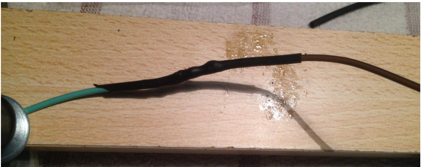
Imagen 30: funda termo retráctil en empalme
