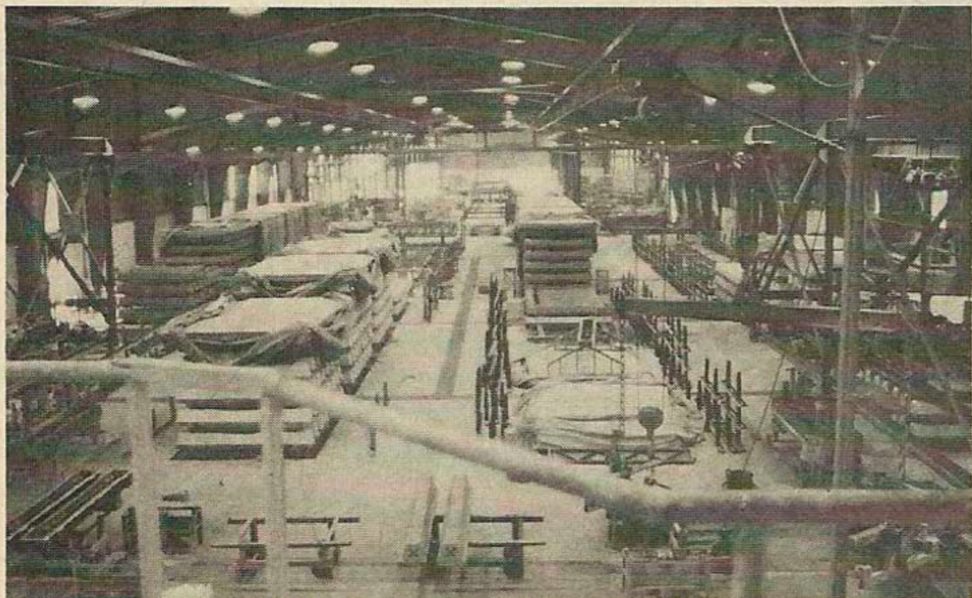
Nave de fabricación de traviesas en Luceni (Zaragoza).
