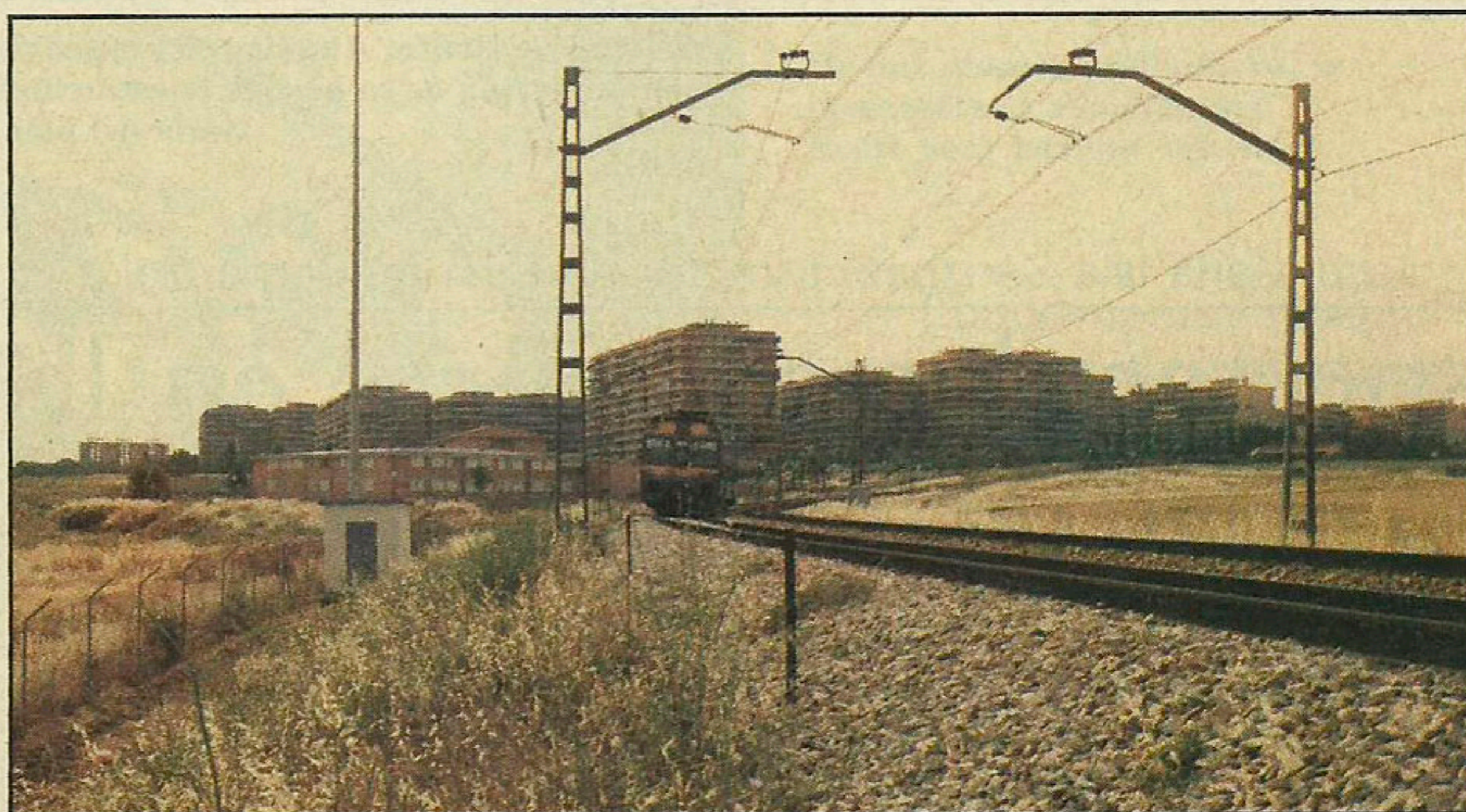
Puesto fijo con su mástil y antena correspondiente.
