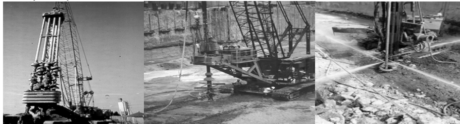
Hình 1. Phương pháp trộn ướt dưới sâu
