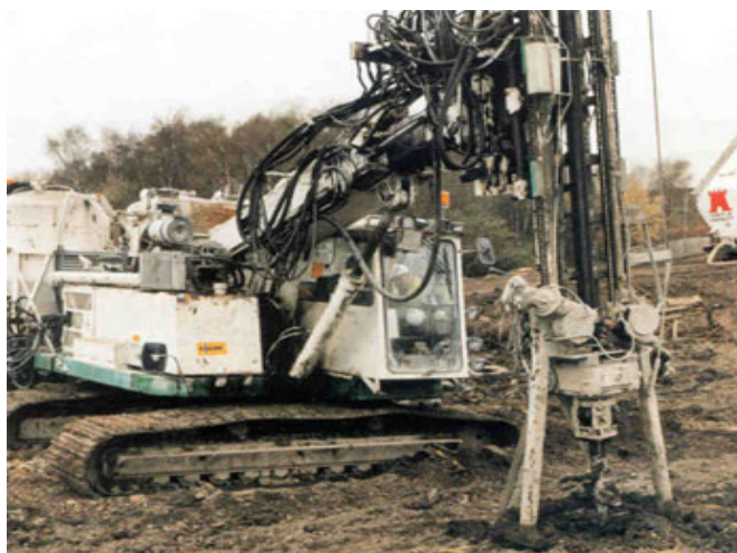
Hình 2. Phương pháp trộn khô dưới sâu
