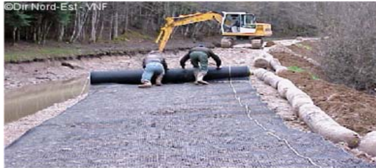
Hình 1.4 - Rải vải địa kỹ thuật trong thi công nền đường
