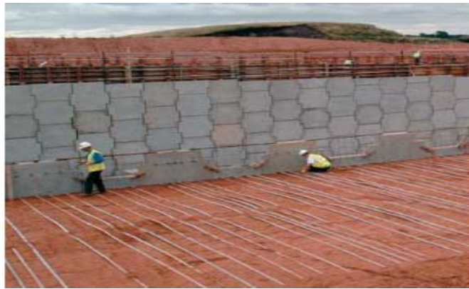
Hình 1.3- Giải pháp đất có cốt trong thi công nền đường
