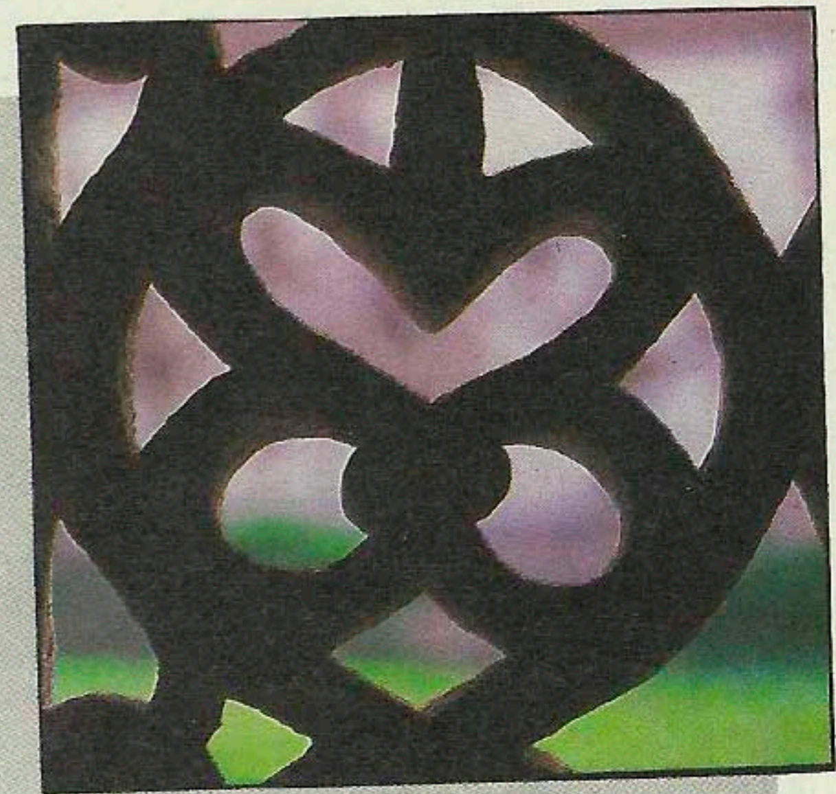
DETALLE DE LA CELOSIA DEL CONVENTIN DE VALDEDIOS
