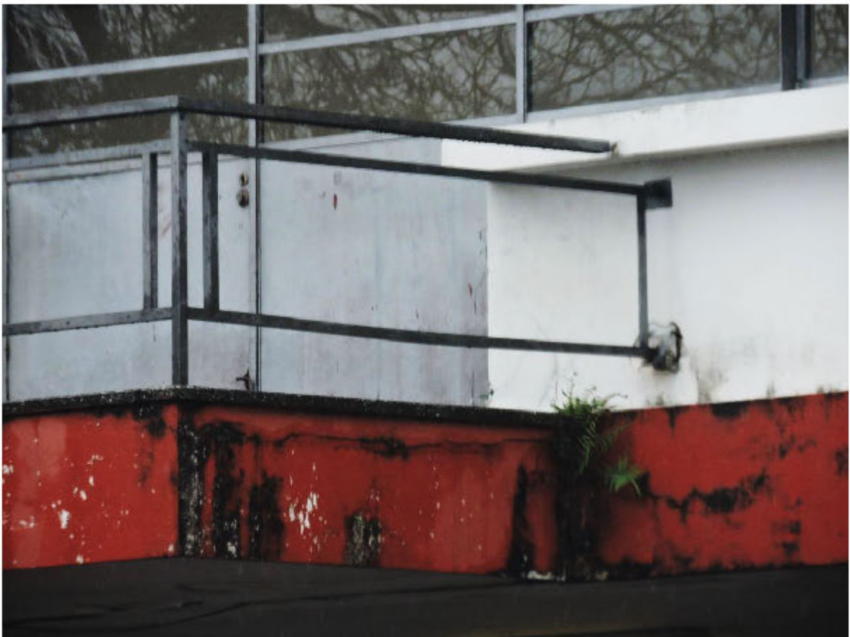
Humedades en muros exteriores
