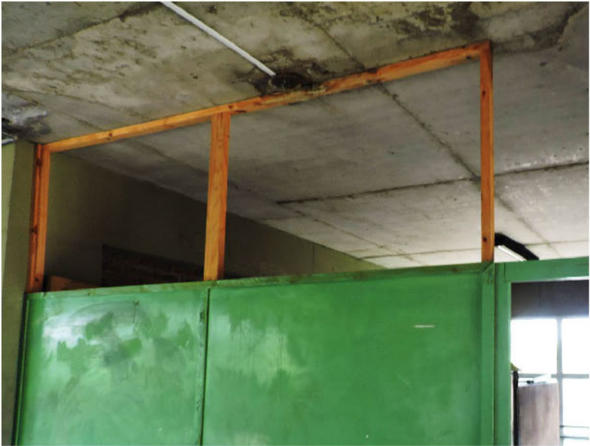
Baños del primer piso (usados como depósitos)
