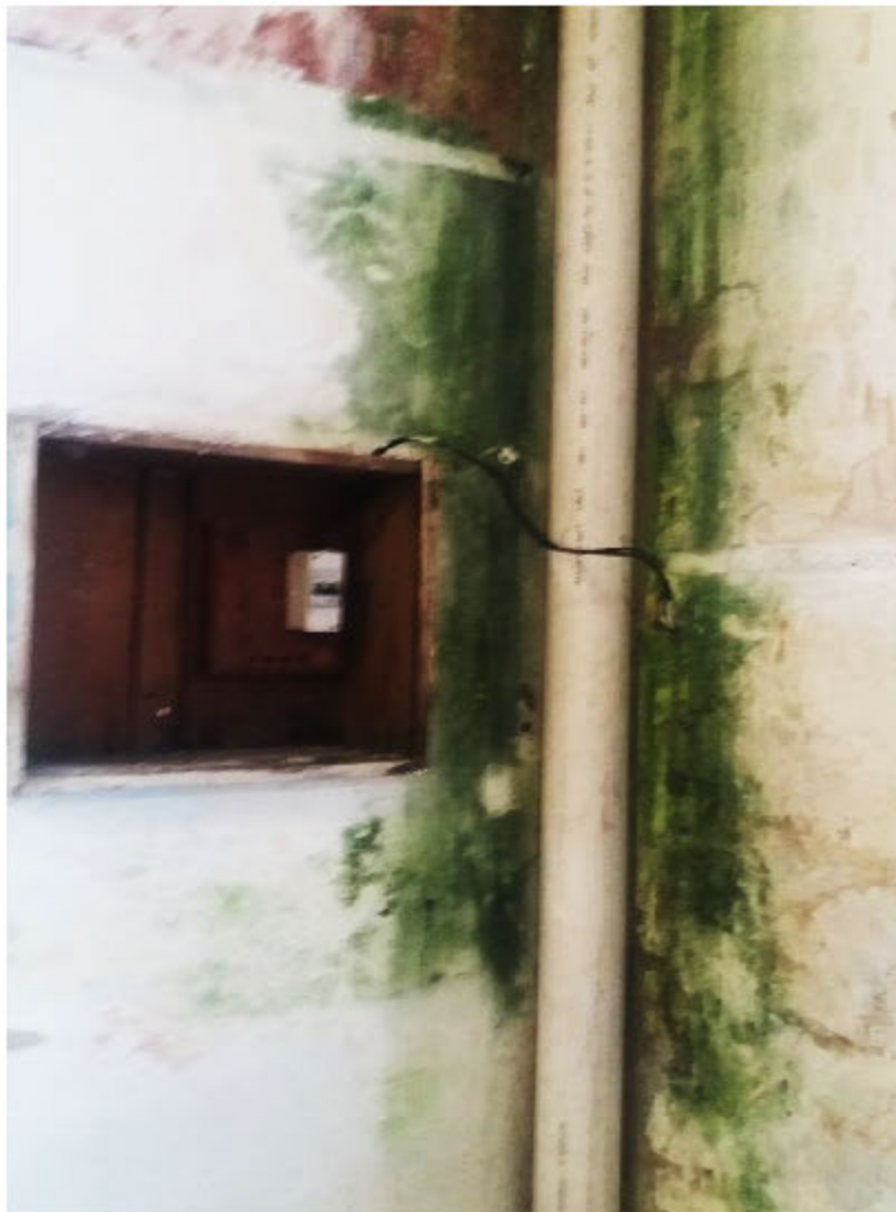
Rastros de agua cerca de instalaciones eléctricas
