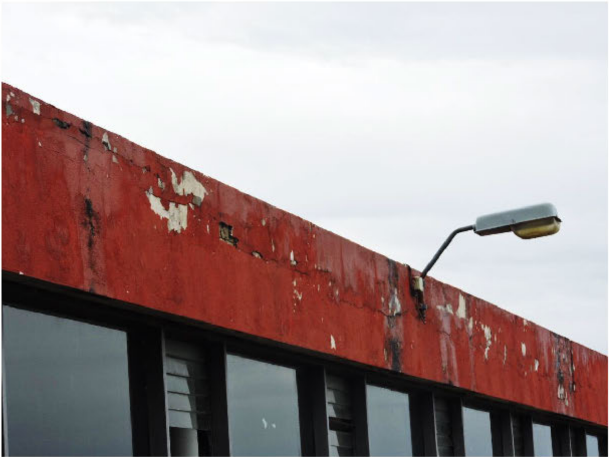
Humedades en muros exteriores
