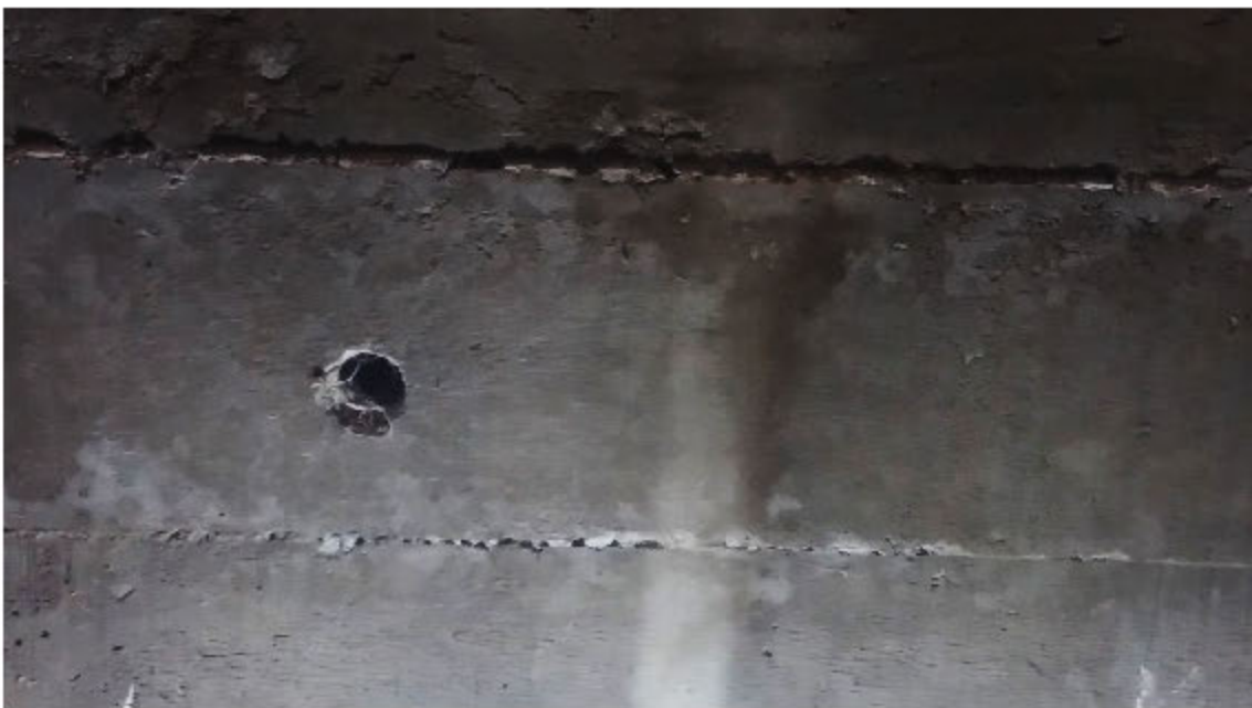
Filtración de agua desde azotea
