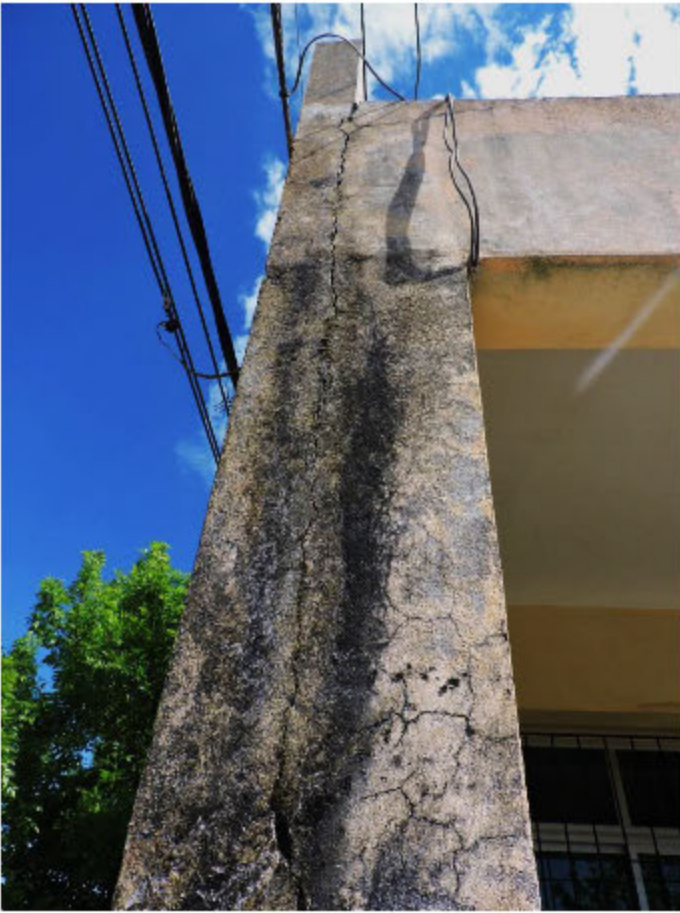
Filtraciones de agua en la claraboya
