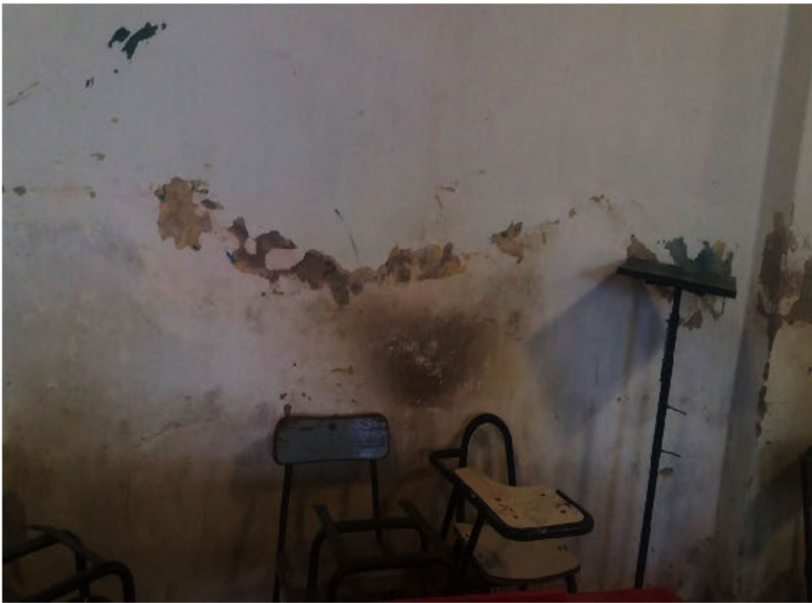
Rastros de agua cerca de instalaciones eléctricas
