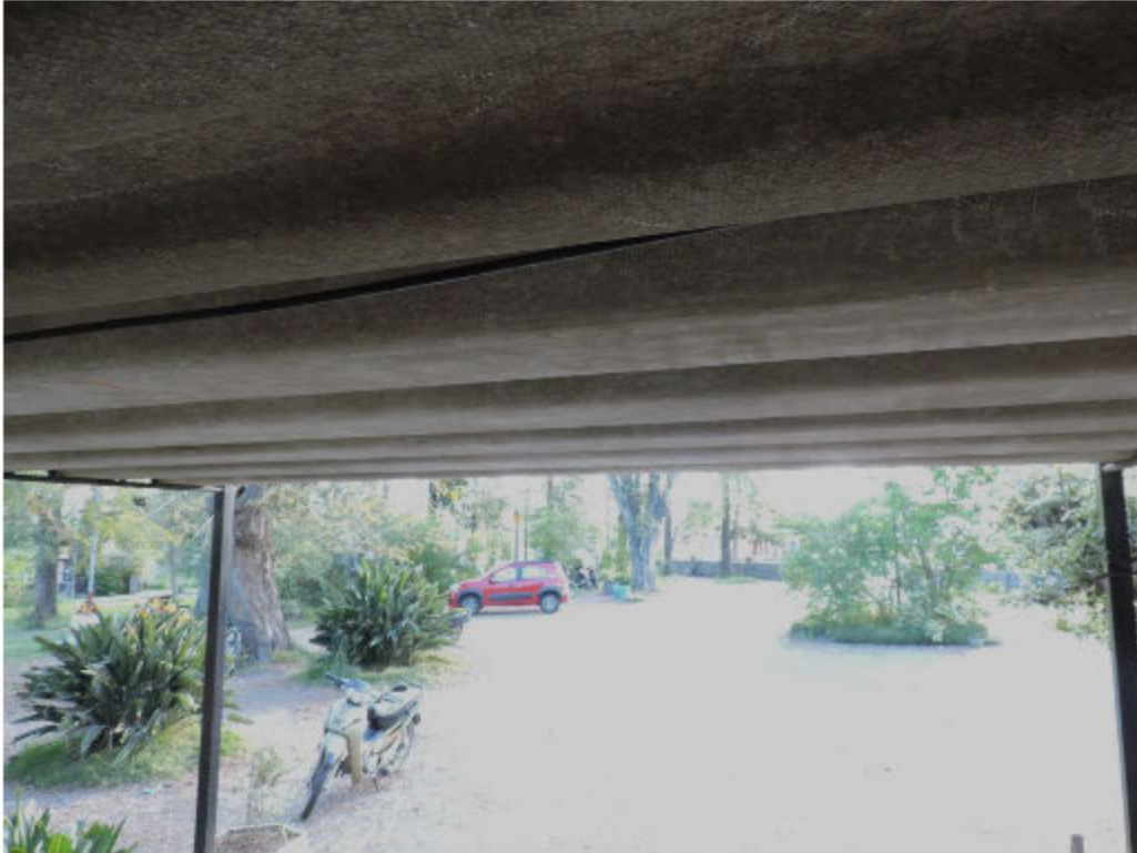
Filtración de agua desde azotea
