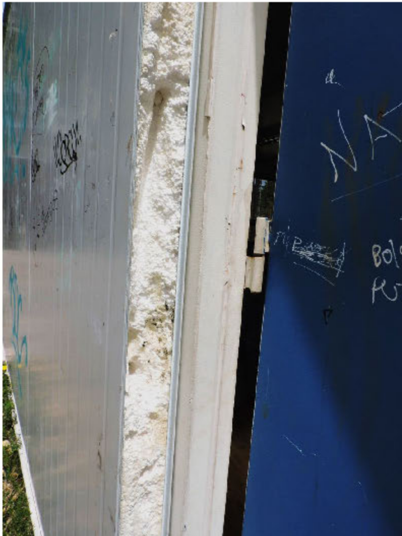
Roturas en placa de contenedor
