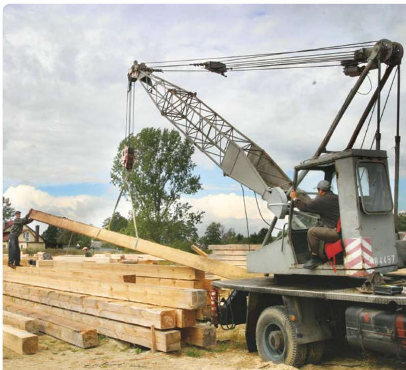
► Często do montażu ciężkich bali pełnych trzeba wynająć dźwig
