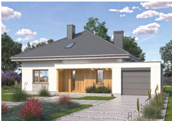
Garaż „dostawiony” do budynku (A116AG1)
