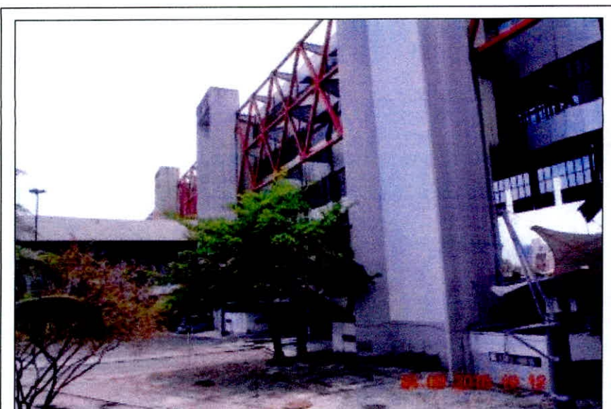
FOTO 06 – Fachada Centro de Convenções (fachada oeste)
