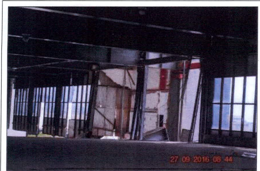
FOTO 19 – Vigas e laje do piso 33
