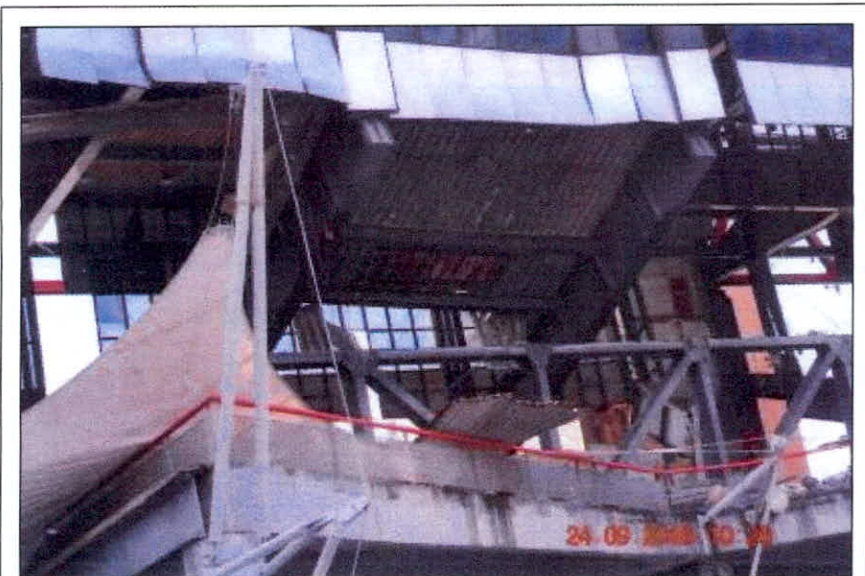
FOTO 10 – Estrutura aquário fixada no piso 33
