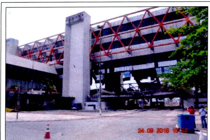
FOTO 05 – Fachada Centro de Convenções (fachada oeste)
