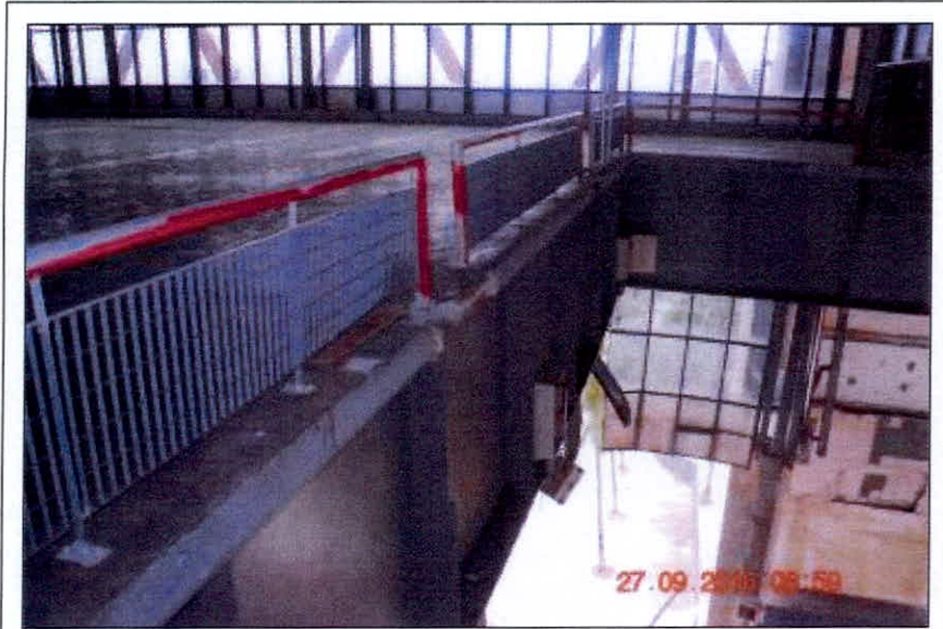
FOTO 27 – Piso 42 fixação escadas rolantes
