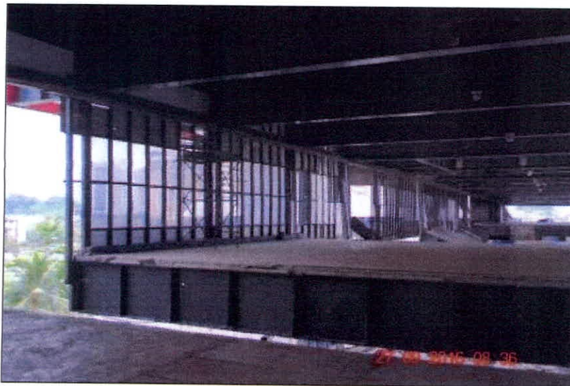
FOTO 16 – Vigas e laje do piso 33
