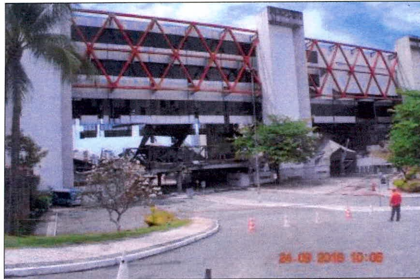
FOTO 03 – Fachada Centro de Convenções (fachada oeste)
