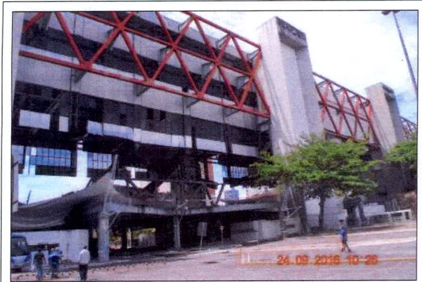
FOTO 09 – Fachada Centro de Convenções (fachada oeste)
