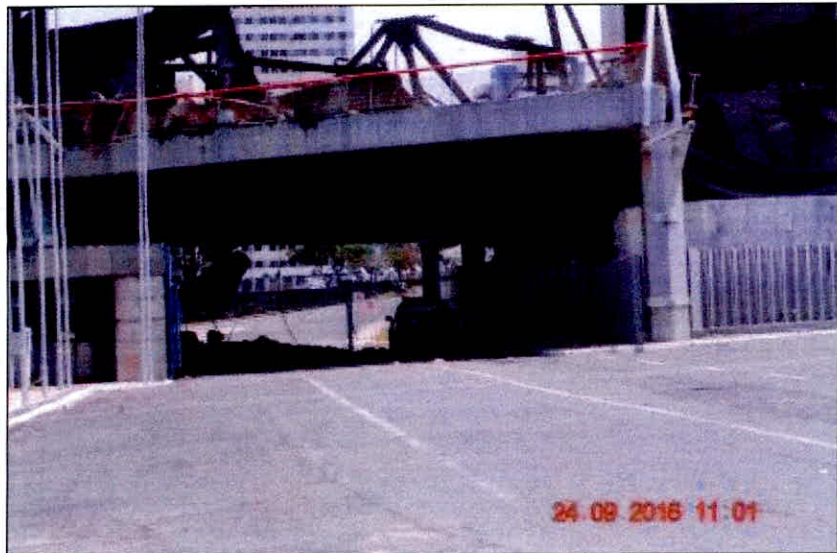
FOTO 14 – Danos do desabamento atingindo veículo
