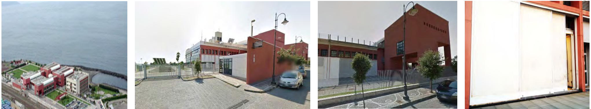
Situation of the building after the works / Stato dell'edificio dopo i lavori
