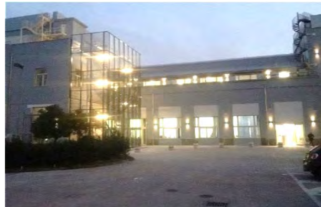
State of the building after the work. Made interventions: shaving and painting of facades, roof Alucobond, lining curtain wall of stairwells, photovoltaic system / Stato dell' edificio dopo il lavoro. Interventi effettuati: rasatura e pittura delle facciate, tetto in Alucobond, rivestimento in facciata continua del corpo scale, impianto fotovoltaico
