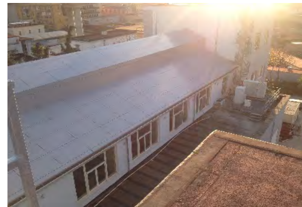
State of the building after the work. Made interventions: shaving and painting of facades, roof Alucobond, lining curtain wall of stairwells, photovoltaic system / Stato dell' edificio dopo il lavoro. Interventi effettuati: rasatura e pittura delle facciate, tetto in Alucobond, rivestimento in facciata continua del corpo scale, impianto fotovoltaico
