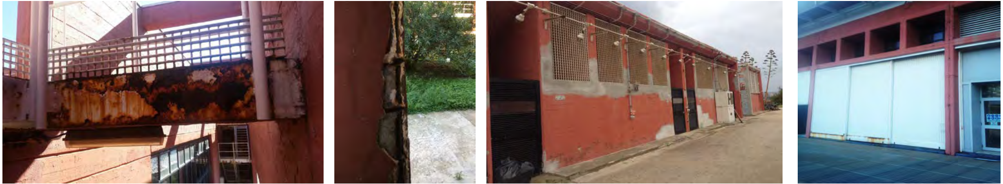
Situation of the building before the works / Stato dell'edificio edifici prima dei lavori
