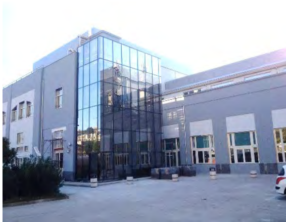
State of the building after the work. Made interventions: shaving and painting of facades, roof Alucobond, lining curtain wall of stairwells, photovoltaic system / Stato dell' edificio dopo il lavoro. Interventi effettuati: rasatura e pittura delle facciate, tetto in Alucobond, rivestimento in facciata continua del corpo scale, impianto fotovoltaico
