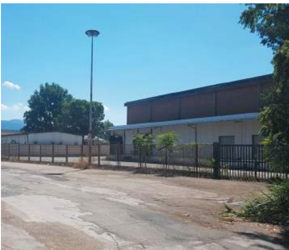
Foro Boario Il mattatoio, dove si lavorerà ancora domani. Poi trasferimento e demolizione per far spazio al cantiere
