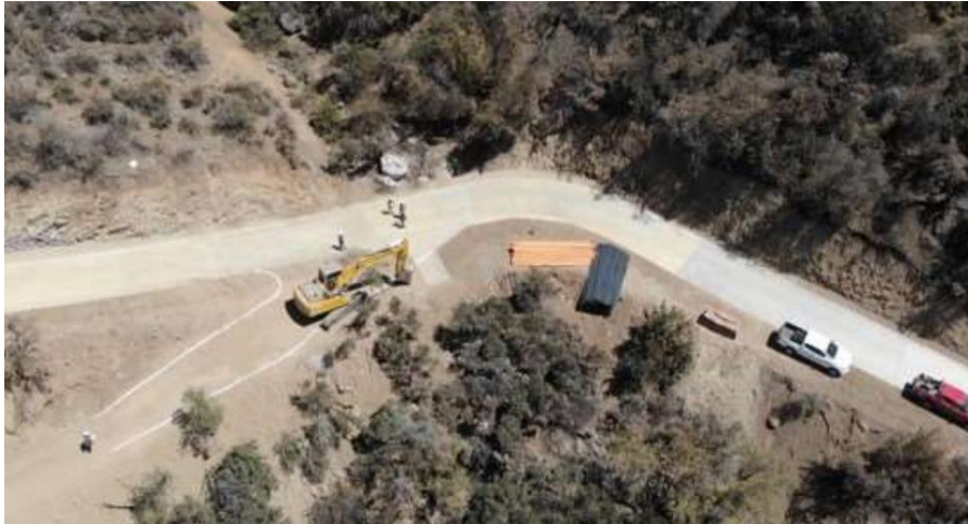
Imagen 4. Detalle de obras de urbanización, proyecto Chaguay. Fuente: denuncia ciudadana.
