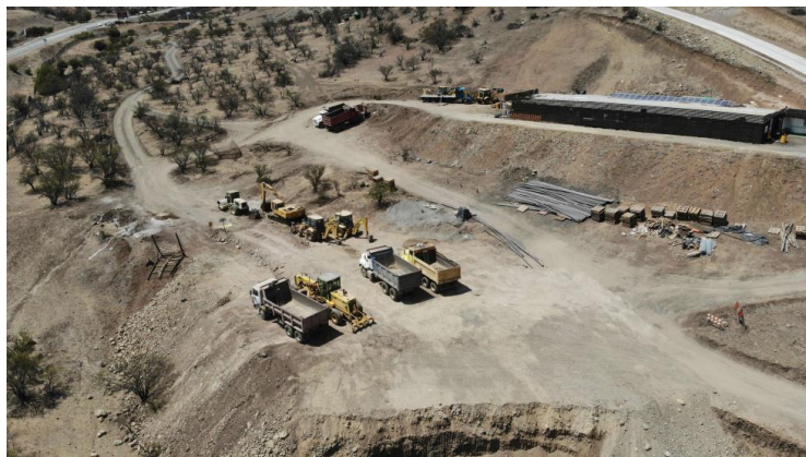
Imagen 5. Obras de urbanización, La Cumbre. Fuente: denuncia ciudadana.
