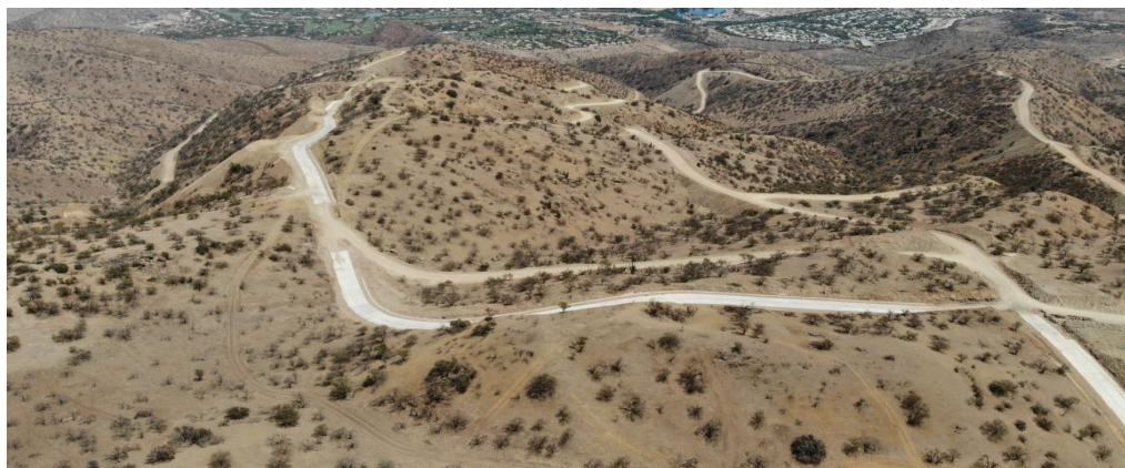
Imagen 7. Obras de urbanización, La Cumbre. Fuente: denuncia ciudadana.
