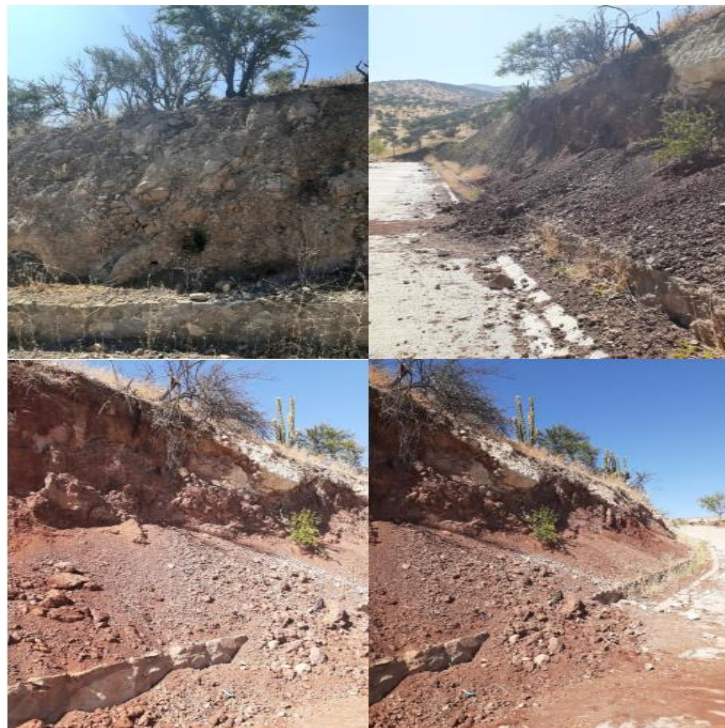
Imagen 9. Procesos de remoción en masa que demuestra la inestabilidad de taludes en un sustrato que sustenta vegetación, área del proyecto Mirador Andino. Fuente: SAG 25 .
