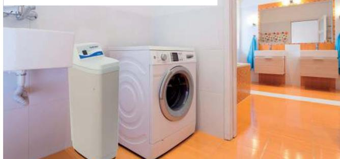
L'adoucisseur permet, pour l'ensemble de votre installation, de modifier une eau « dure » chargée de calcaire en eau « douce », grâce à une résine qui retient les ions de calcium et de magnésium, à l'origine de la formation du calcaire. L'adoucisseur est composé de deux parties :
