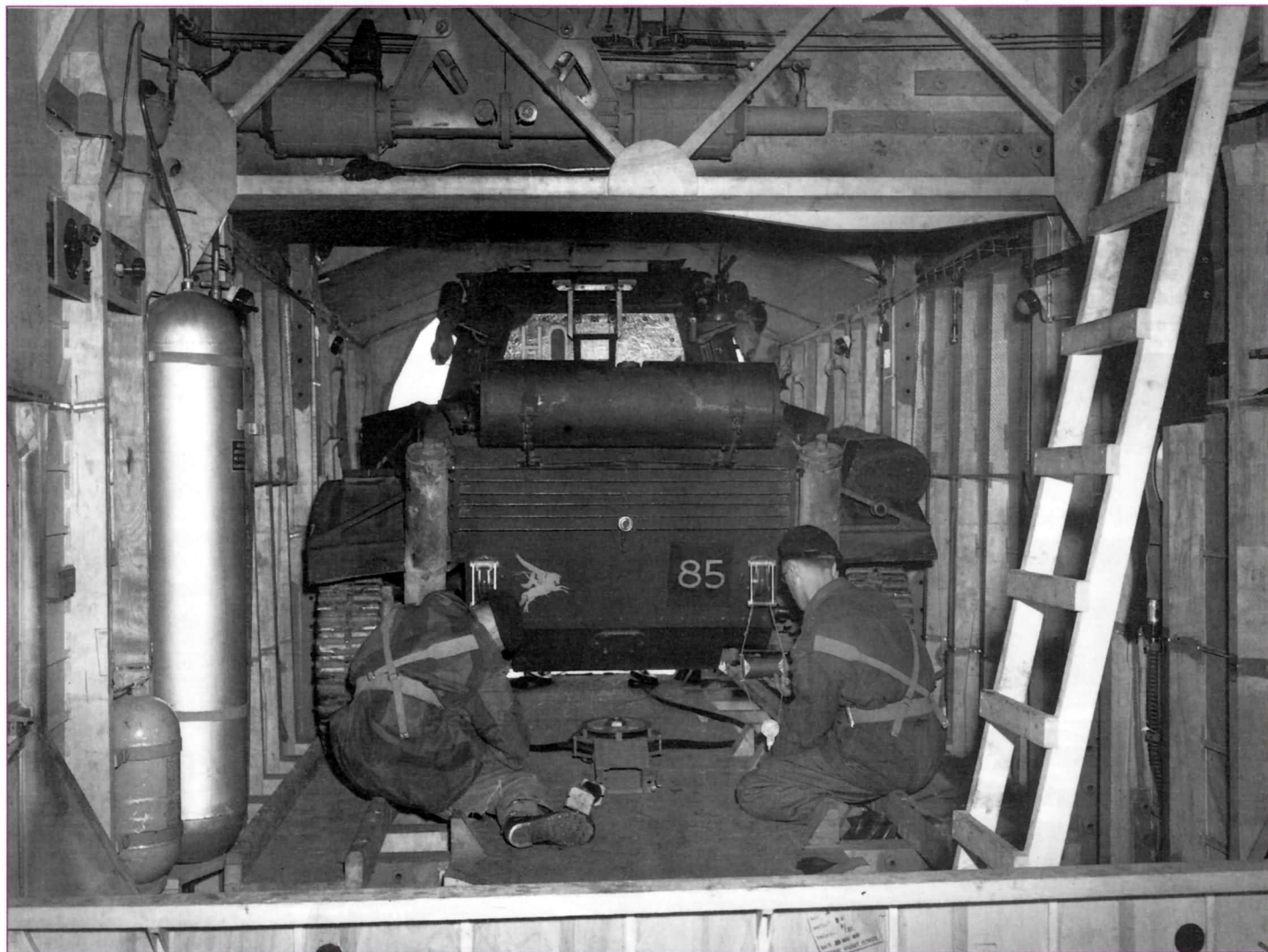
Un char «Tertrach» dans le planeur en bois «Hamilcar», vu vers l'avant. Noter l'échelle d'accès vers le toit et le poste de pilotage. (IWM)
