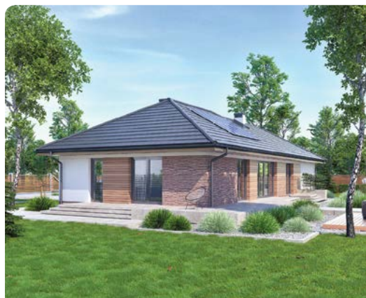
▶ Duży narożny taras (44,1 m 2 ) został wyniesiony nad poziom terenu. Taką imponującą tarasową przestrzeń kontynuuje mniejszy (5,5 m 2 ) przy sypialni gospodarzy. Granicę między nimi zaznaczają tarasowe schody
