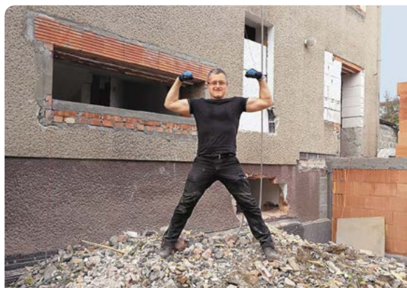
► Pan Mirosław – inwestor na budowie. Sam prowadził prace wyburzeniowe, a potem doglądał prac budowlanych
