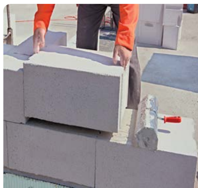
► Bloczki z betonu komórkowego mają krawędzie wyprofilowane tak, by dało się je łączyć na wpust i wypust. Nie trzeba wtedy robić spoin pionowych
