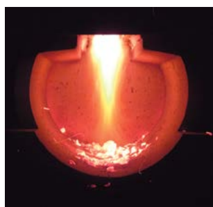
plomień w komorze spalania kotła zgazującego
