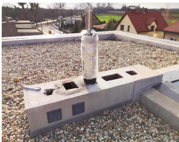
► Nowy stropodach – koniecznie z izolacją termiczną i hydroizolacją
