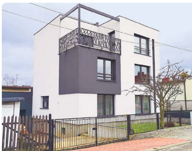
► Efekt końcowy – nowoczesna elewacja budynku, zróżnicowana kolorystycznie, z elementami industrialnymi
