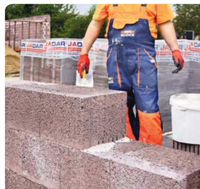
► Pustaki z keramzytobetonu mają często zasklepione otwory, żeby nie dostawała się do nich zaprawa murarska
