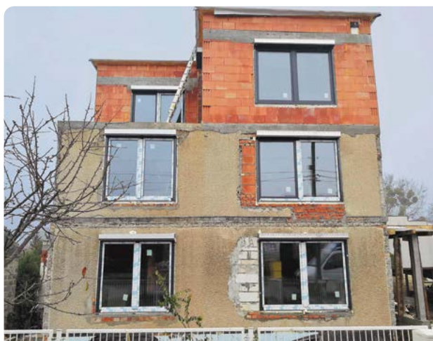
► Dodatkową kondygnację wykonano z ceramiki poryzowanej. Ocieplenie domu ze styropianu, okna trójszybowe
