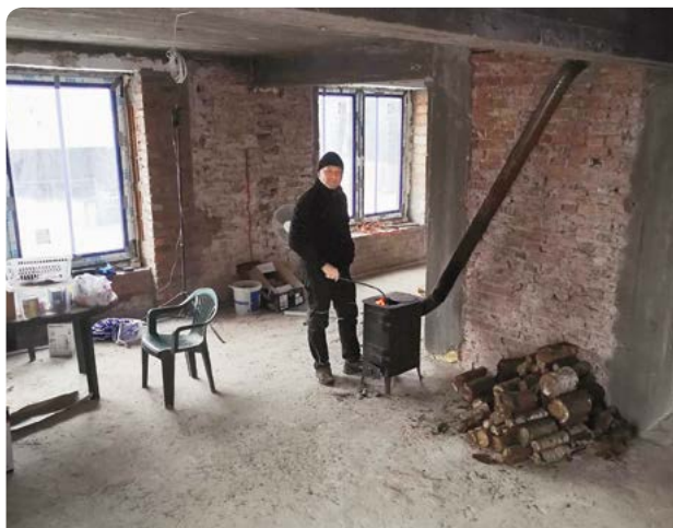
► Pierwsze piętro – salon z kuchnią. W ścianie pośrodku ukryty jest słup konstrukcyjny podtrzymujący strop
