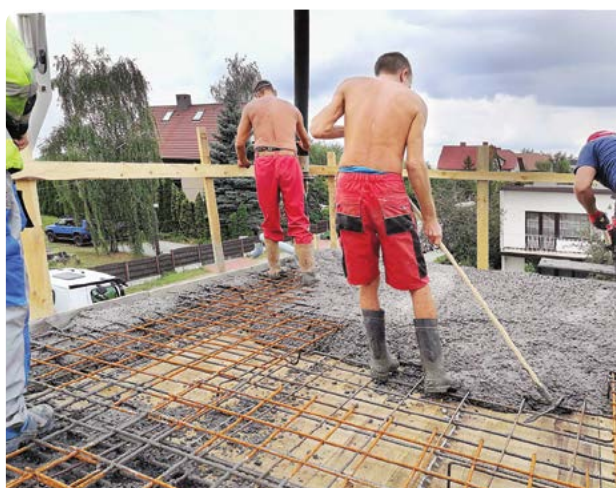
► Stropy, także nowy stropodach, są monolityczne. Żelbet najskuteczniej spina ściany domu
