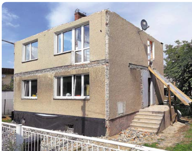
► Efekt prac wyburzeniowych – zdemontowano stropodach
