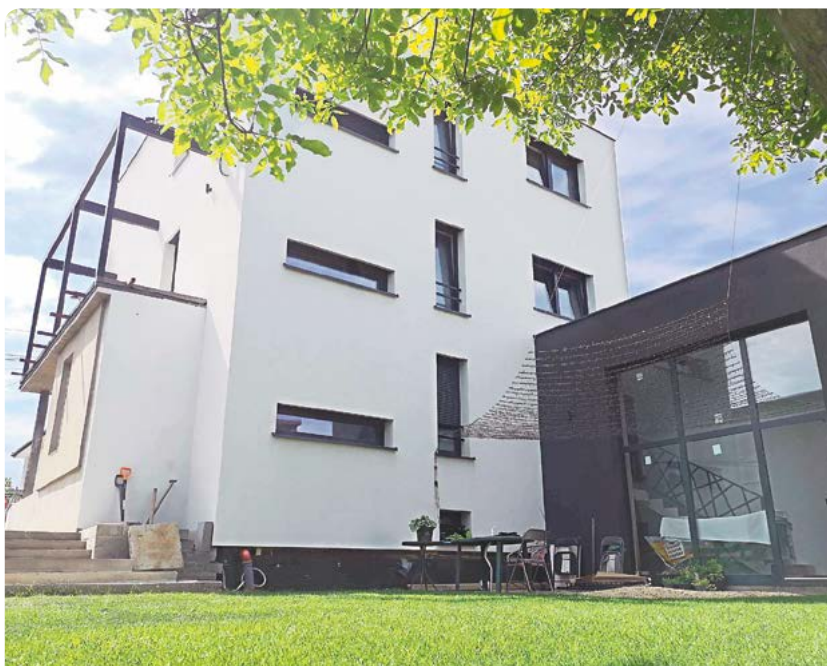
► Budynek został podwyższony o jedną kondygnację. Od strony ogrodu nowa strefa wejściowa prowadzi do mieszkania seniorki rodziny
