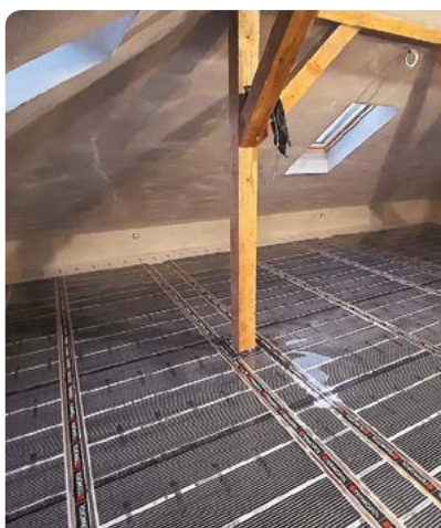
106 Fotowoltaika z podłogówką
