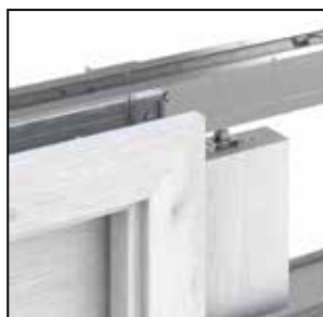
construcția casetei metalice
