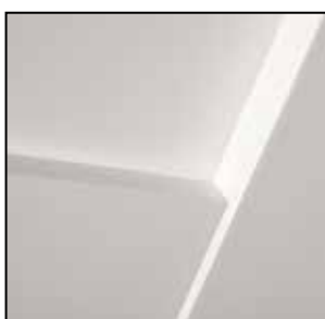
construcția ramă și panou
