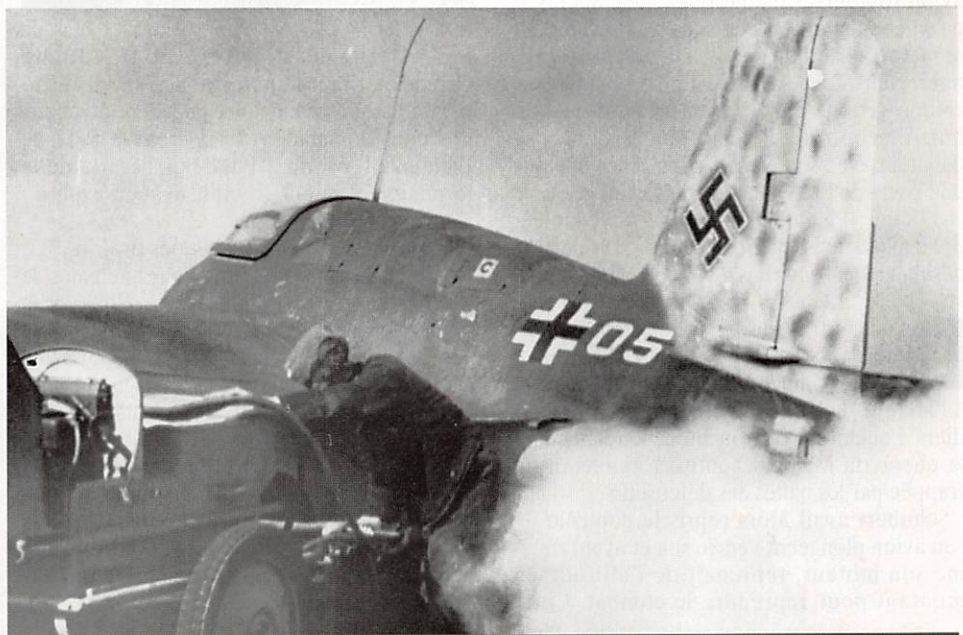
De la vapeur jaillit de la tuyère de la pompe à propergols d'un Me 163B, tandis qu'un mécanicien éloigne le chariot d'accumulateurs qui fournissent l'énergie électrique nécessaire à l'allumage du moteur-fusée.
