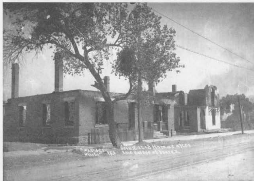
Arriba: Siniestros paredones a punto de derrumbarse son sobrevivientes de una ciudad ultrajada y ofrecen un espectáculo de desoladores panoramas
