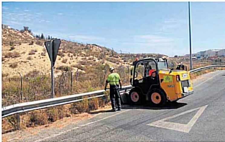
Tareas de limpieza en una cuneta de una carretera del municipio, esta semana. AVTO
