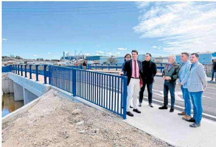
Autoridades y técnicos, ayer, en el puente levantado sobre la rambla. AVTO.
