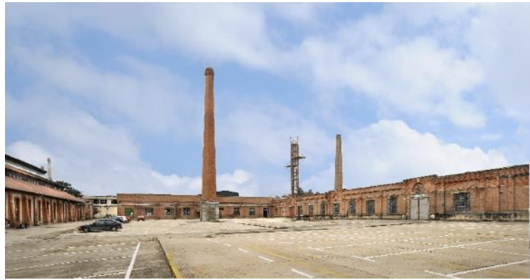
Слика 62. Димњак старе котларе
