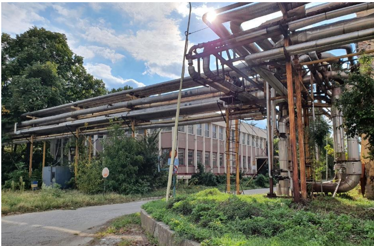
Слика 98. Водови енерго-флуида
