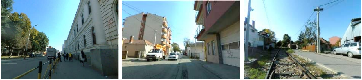
Слика 39. Косовска улица у зони Машинско-техничке школе; Слика 40. Изграђена структура у Косовској улици; Слика 41. Траса индустријског колосека кроз део стамбене зоне
