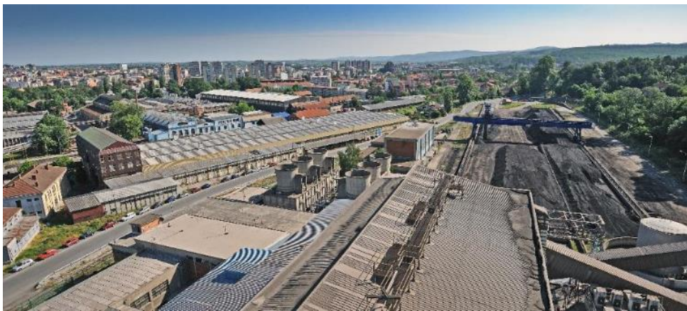
Слика 42. Панорамски приказ комплекса са јужне стране комплекса -поглед на пепелиште-део зоне 3.2 и део објекта топлане-зона 4.2 (крупни план)
