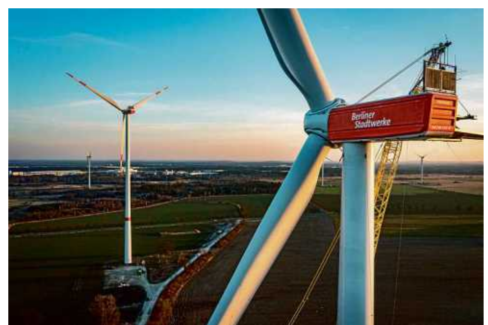
Windenergieanlage der Berliner Stadtwerke im Windpark Teltow II. Insgesamt betreibt das Energiewende-Unternehmen 16 eigene Windräder.
